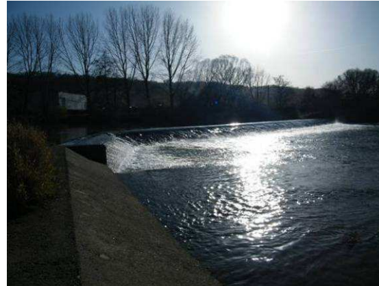
Barrage infranchissable sur le Doubs au niveau de Voujeaucourt © O.G.E
