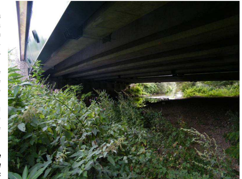
Ouvrage de franchissement de la Savoureuse par l'A36 (cliché du 10/08/2010) © O.G.E.
