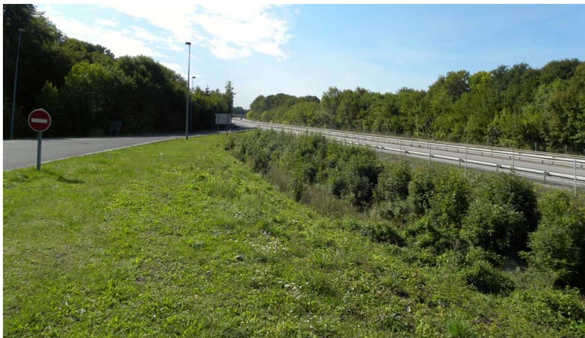
Vue en direction de l'ouest : entrée de l'aire de service et bassin de rétention
