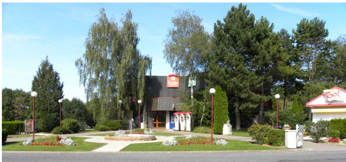
Vue en direction du nord : entrée restaurant passerelle + snack
