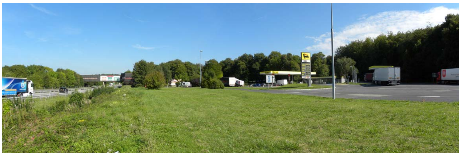
Vue en direction de l'est : entrée de l'aire de service et bassin de rétention
