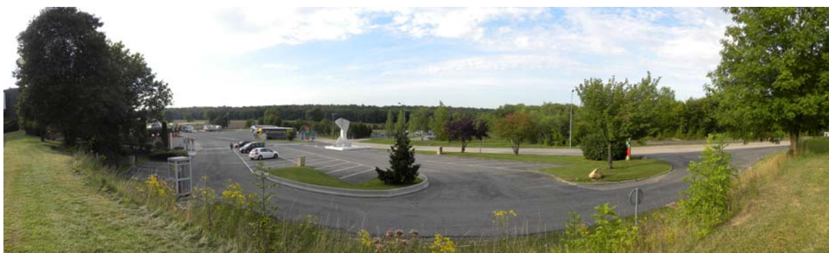
Vue en direction du nord : entrée aire de service + parking VL
