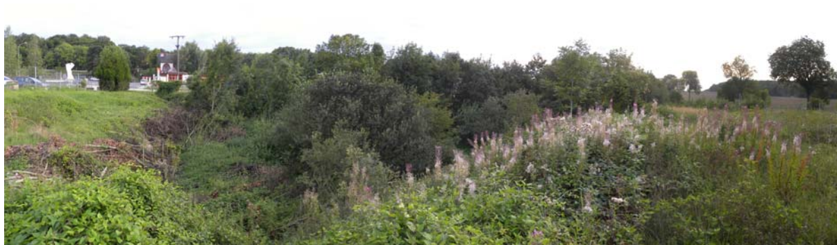
Vue en direction du sud : bassin de rétention/infiltration
