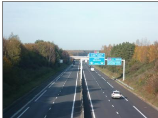
Photographie n°5 : Portique de signalisation
