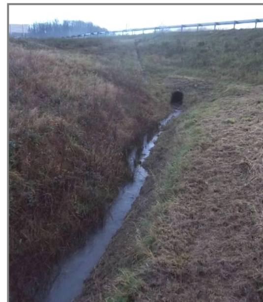
Photographie n°12 : Vue sur le passage busé rétablissant le Verdin sous l'autoroute A71 – Vue vers l'amont à l'aval de l'autoroute
