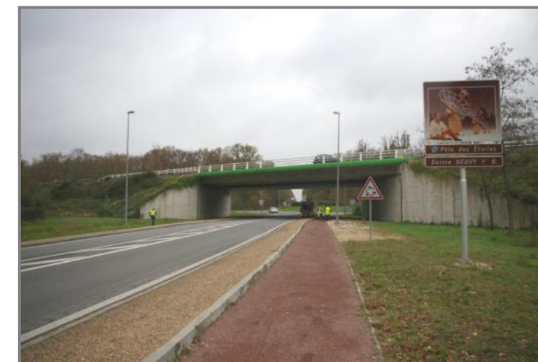
Photographie n°4 : Passage inférieur (PR 176+ 918) : RD 2020 (Source : INGEROP, novembre 2011)
