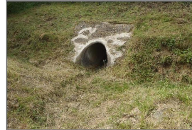
Photographie n°13 : Passage busé de l'affluent 1 sous l'autoroute A71 – Vue vers l'aval (amont de l'autoroute A71) (Source : GENIVAR)
