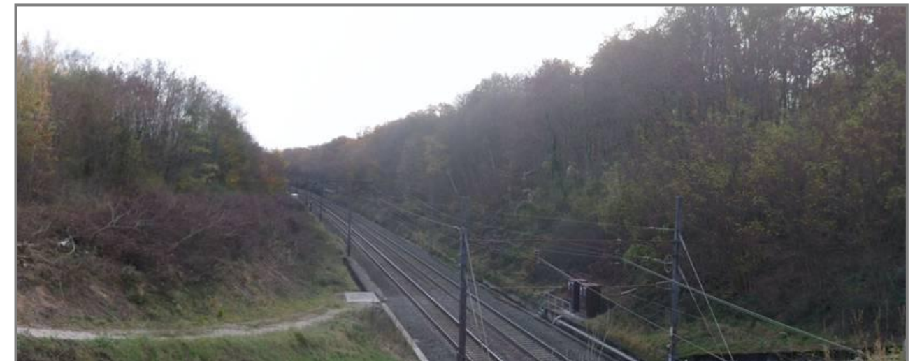
Photographie n°64 : Ligne de la voie ferrée (Paris-Toulouse) (Source : BLG Environnement, 2011)
