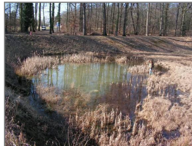
Photographie n°48 : Bassin n°4 au niveau du centre autoroutier
