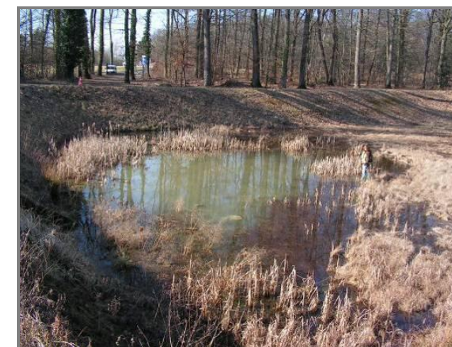
Figure 102 : Bassin n° 71B1771 au niveau du centre autoroutier
