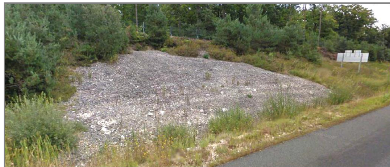
Figure 14 : Exemple de masque poids réalisé sur le talus de déblai (PR 176,450)
