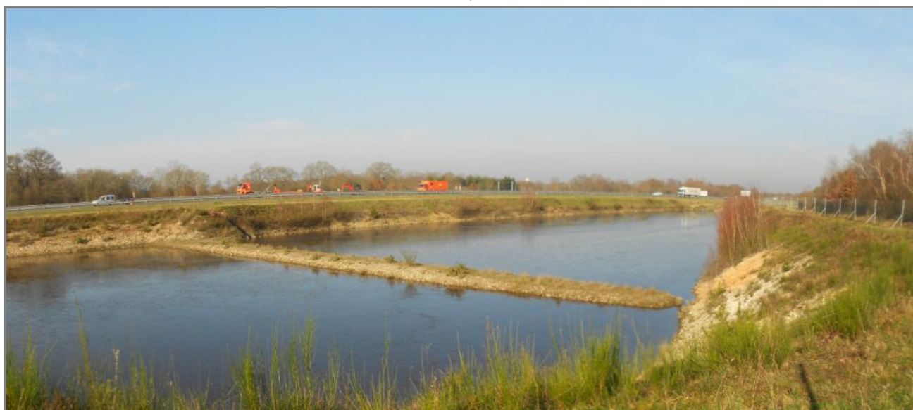
Figure 39 : Bassin de rétention n° 71B1722 situé au nord de l'échangeur A71/A85 (Source : BLG Environnement, 2012)
