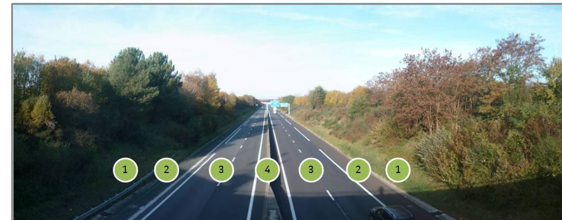
Photographie n°1 : Vue sur l'autoroute A71
