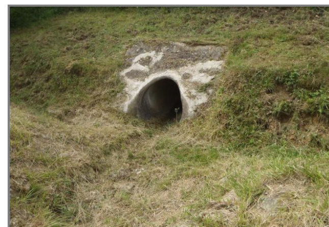
Figure 35 : Passage busé de l'affluent 1 sous l'autoroute A71 – Vue vers l'aval (amont de l'autoroute A71)
