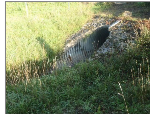
Photographie n°15 : Passage busé de l'affluent 2 sous l'autoroute A71 – Vue vers l'amont (aval de l'autoroute A71) (Source : GENIVAR)
