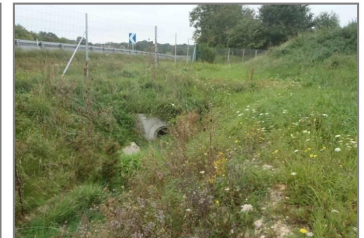
Photographie n°16 : Passage busé de l'affluent 3 sous l'autoroute A71 – Vue vers l'amont (aval de l'autoroute A71) (Source : GENIVAR)
