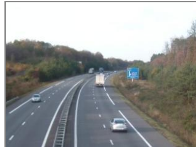
Photographie n°6 : Signalisation directionnelle
