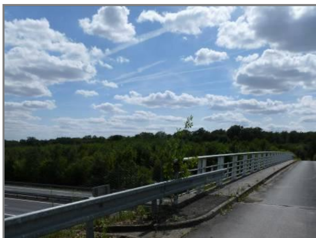
Figure 126 : Pont permettant le passage des chauves-souris (Source : BIOTOPE)
