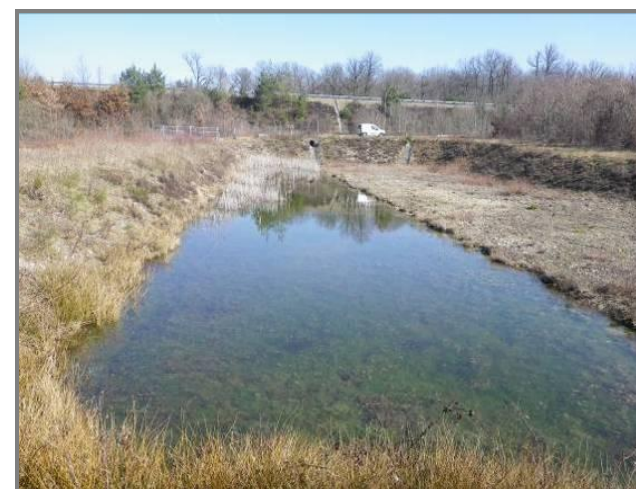
Figure 101 : Bassin n° 71B1758 au niveau du passage inférieur
