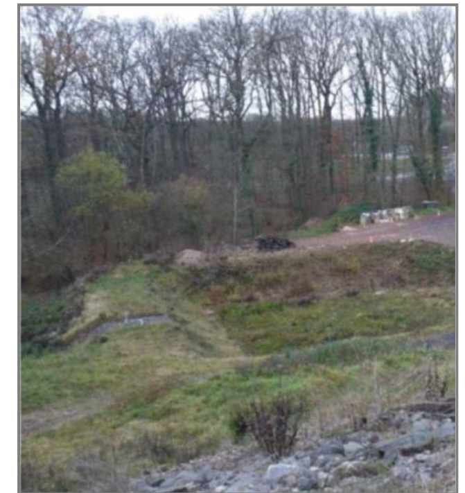
Photographie n°75 : Vue K – Bassin de rétention (Source : SETEC, Décembre 2011)
