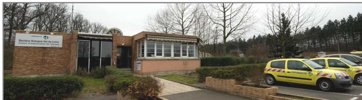
Photographie n°62 : Centre d'exploitation Cofiroute (Source : Cofiroute)
