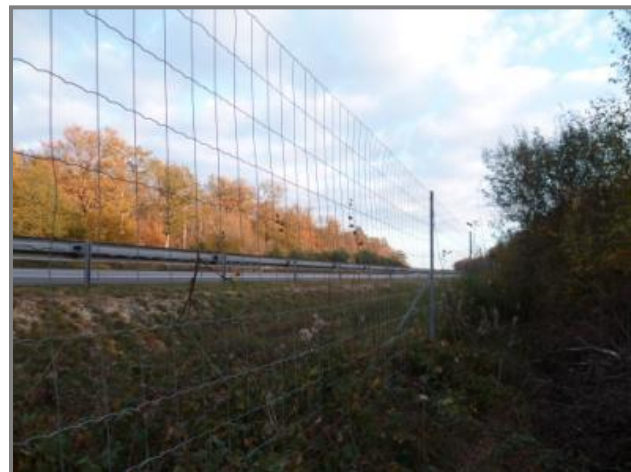
Photographie n°7 : Clôture latérale
