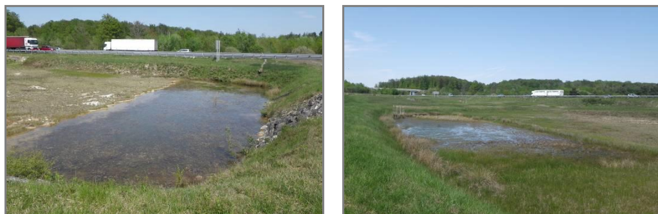
Figure 100 : De gauche à droite : bassin (n° 71B1748) nord et bassin sud (n° 71B1752) au niveau du passage supérieur
