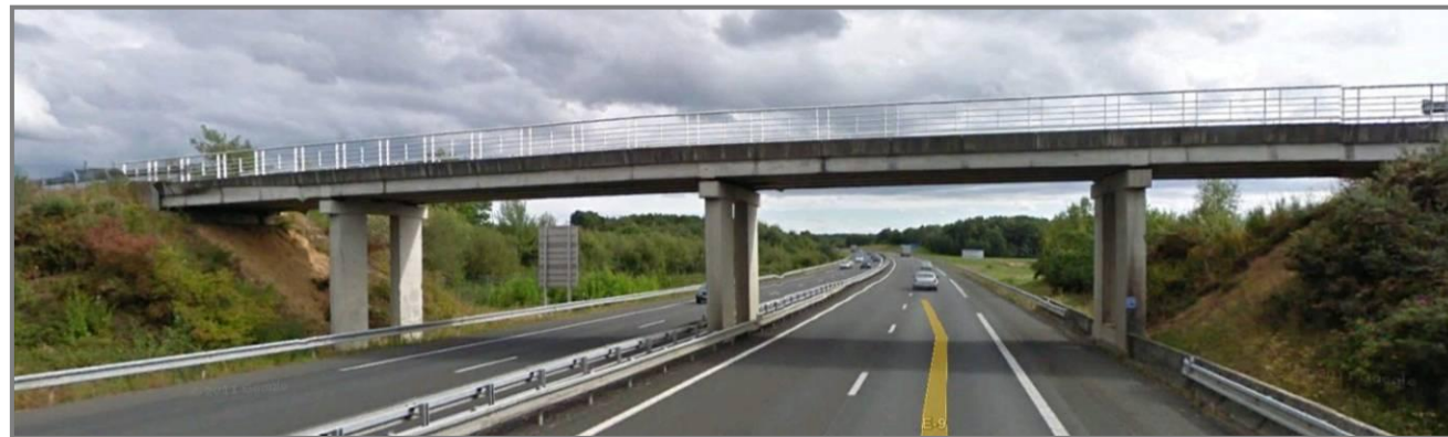
Photographie n°2 : Passage supérieur (PR 174 + 740) sens Paris Vierzon : Route forestière de l'alouette (Source : Google Earth)
