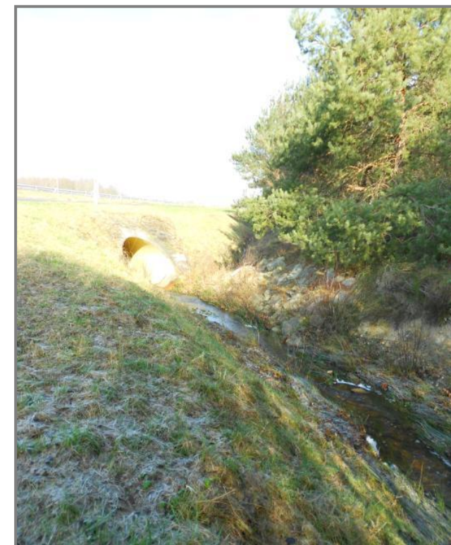
Photographie n°11 : Ouvrage de rétablissement du Rouaire au niveau de l'autoroute A71 - Vue vers l'amont
