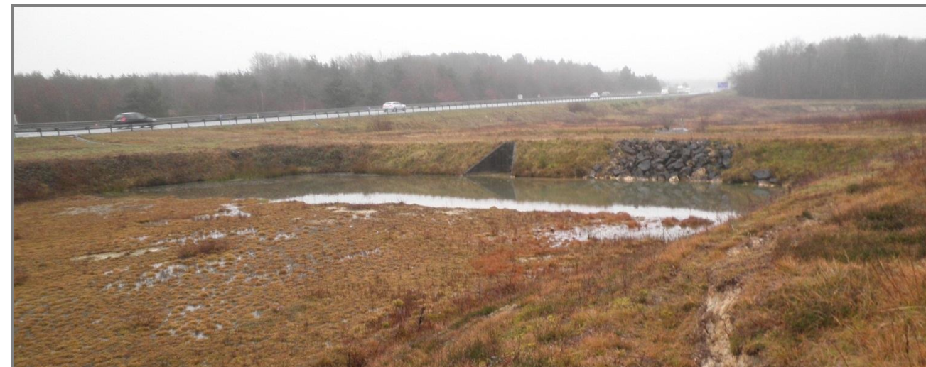
Figure 40 : Bassin de rétention n° 71B1748 situé à proximité de la route forestière de l'Alouette (Source : Ingérop, 2011)
