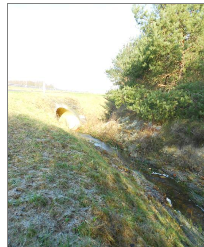
Figure 32 : Ouvrage de rétablissement du Rouaire au niveau de l'autoroute A71 – Vue vers l'amont (Source : BLG Environnement, 2012)
