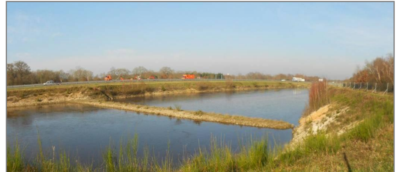
Photographie n°17 : Bassins de rétention situés en amont de l'échangeur A71/A85 (Source : BLG Environnement, 2012)
