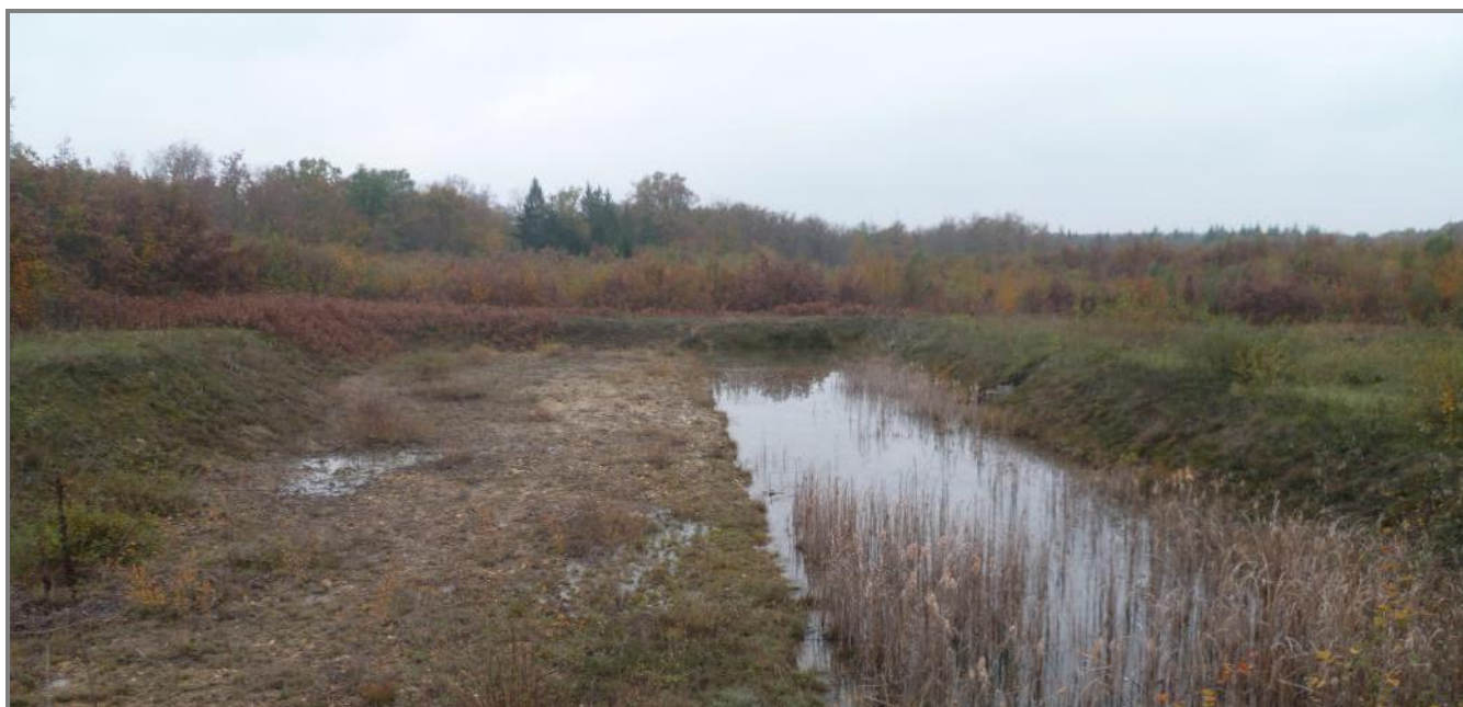
Figure 41 : Bassin de rétention n° 71B1758 situé à proximité de la route forestière de la Plaine (Source : BLG Environnement, 2011)
