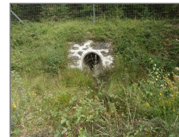
Figure 36 : Passage busé de l'affluent 1 sous l'autoroute A71 – Vue vers l'amont (aval de l'autoroute A71)
