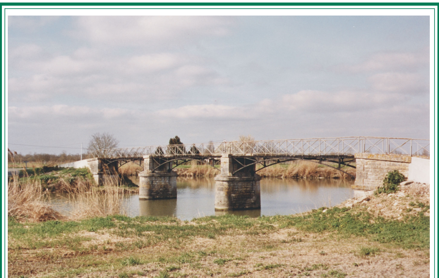
Marais poitevin : ouvrage ( piétons, cycles) sur la Sèvre Niortaise
