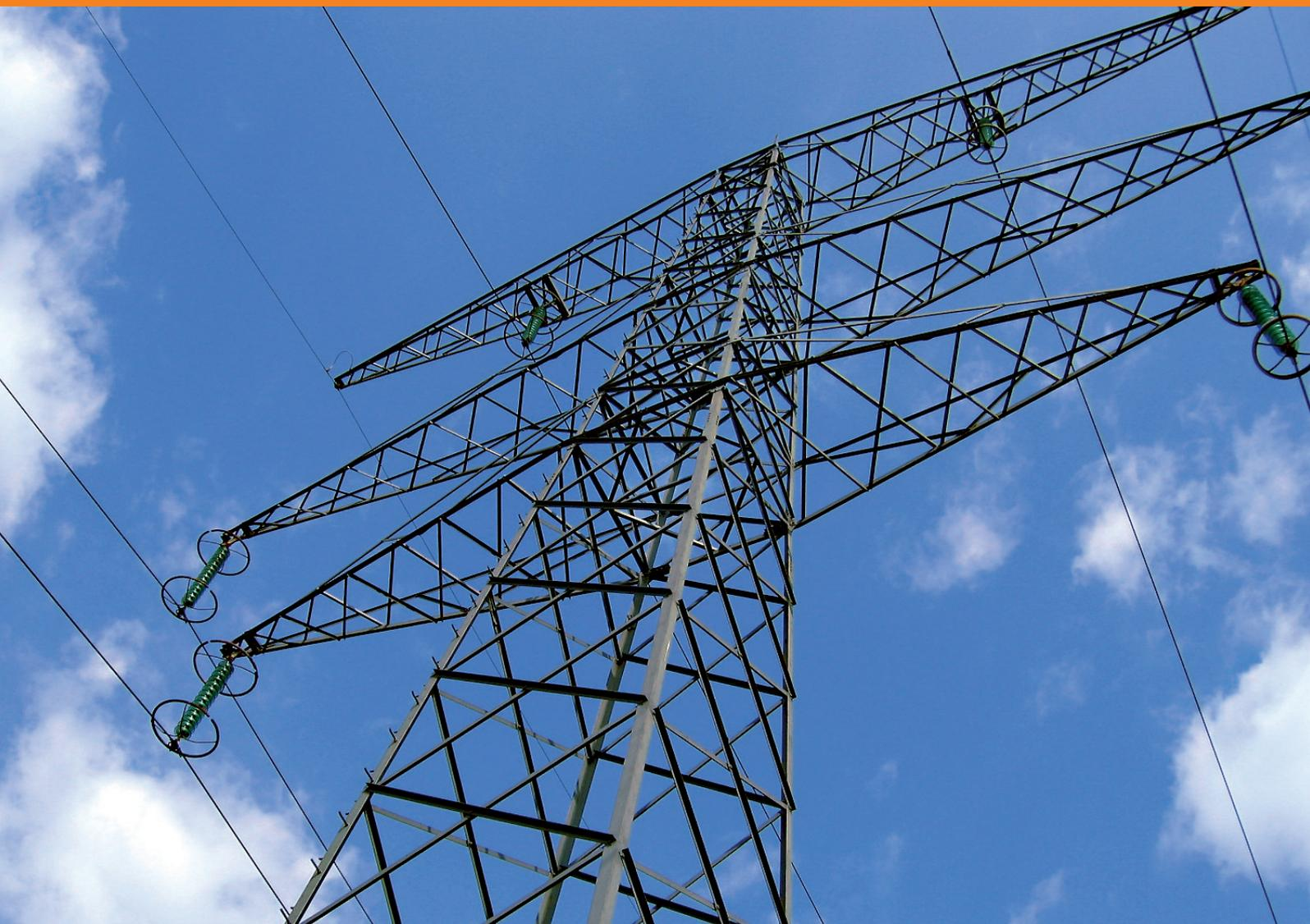
Le transport de l'électricité est réalisé à l'aide de courant alternatif ce qui permet, en élevant la tension de transporter beaucoup d'énergie en minimisant les pertes. Il est réalisé en France par le biais du Réseau Public de Transport (RPT) qui se compose essentiellement de lignes aériennes suspendues à des pylônes.
