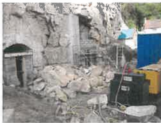
Confortement de falaises à Chars (95)
