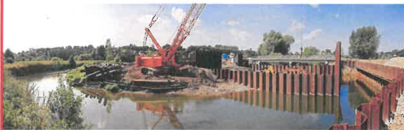
Travaux de prévention du risque inondation : site d'écêtement des fortes crues de l'Oise de Proisy (02) réalisé par l'Entente Oise Aisne et achevé en 2009.
