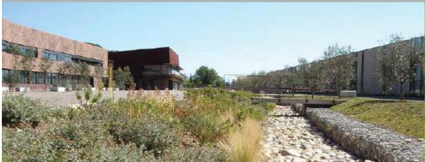
Manosque, 3 ème Lycée : rivière sèche collectant la pluie de la cour.
