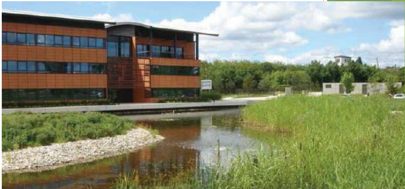
Ecully (69), aménagement d'un parc d'activités : bassin et lagune filtrante 4 mois après la plantation.
