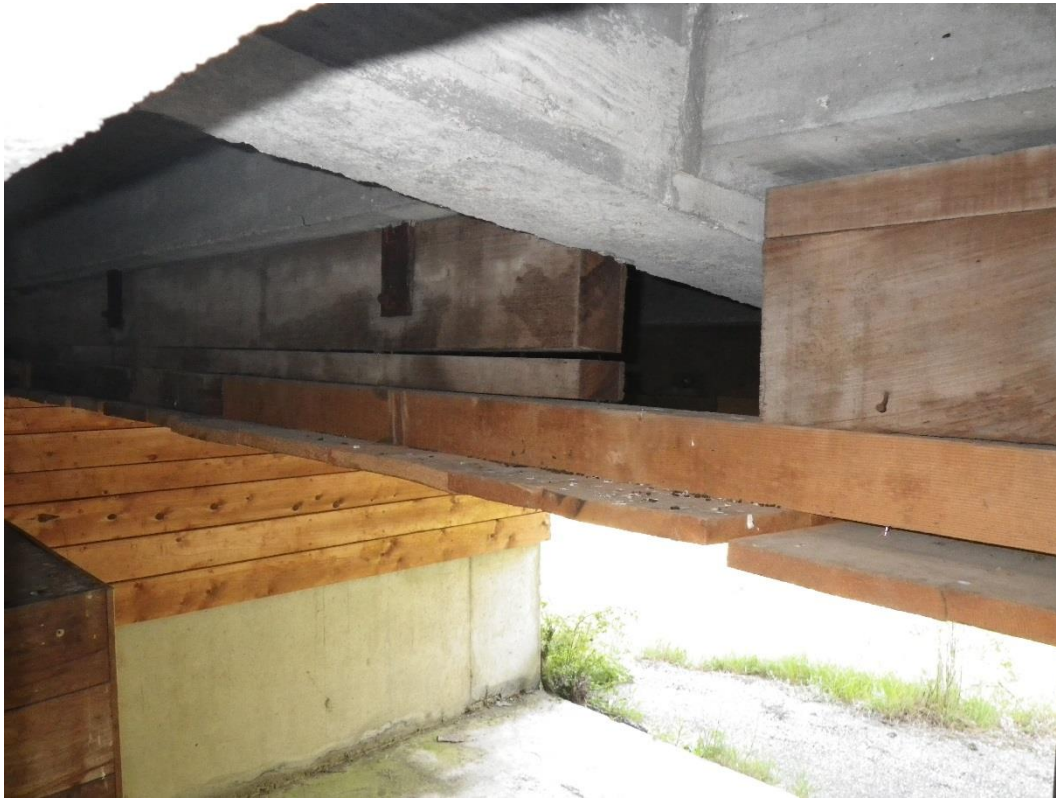
Vue de l'entrée aux combles du pas de tir
