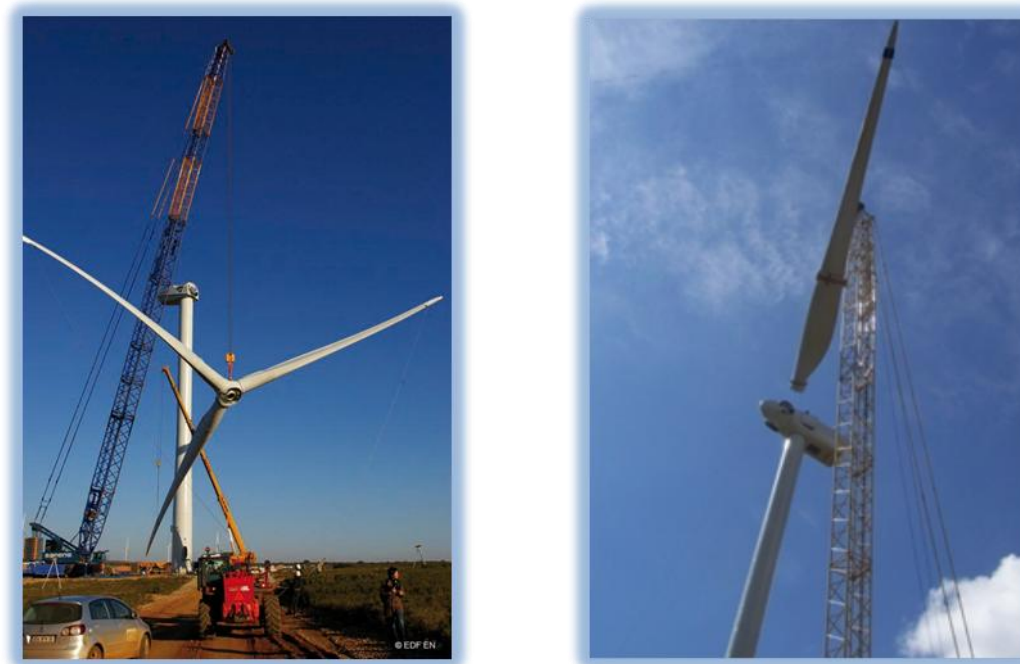
Figure 121 : Montage de l'hélice et montage « pale par pale »
