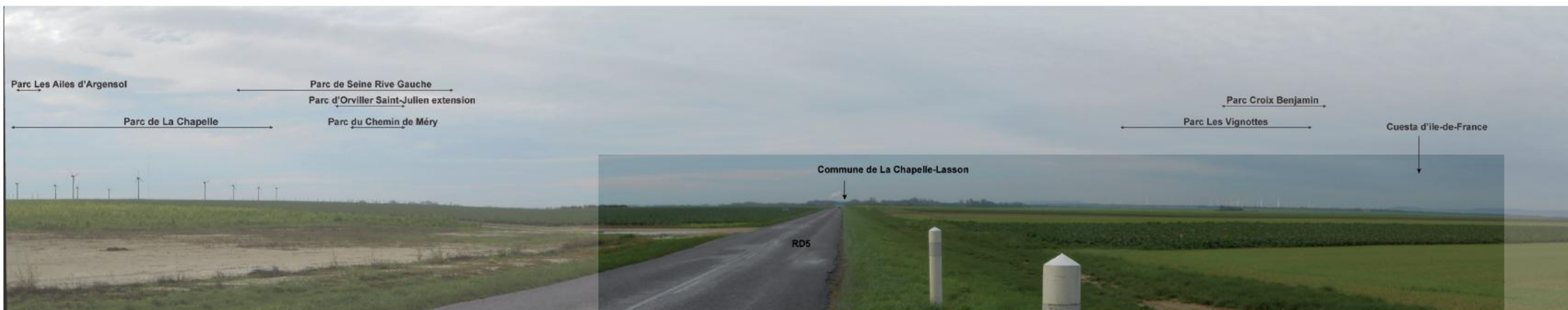
Prise de vue depuis la RD 5 au Nord de La Chapelle-Lasson, la voie parcourt des paysages de plaines très ouvertes. Le parc de 'La Chapelle' est perceptible sur la gauche de la voie. La Cuesta d'Ile de France dessine l'horizon sur la droite, voir ci-dessous (seul relief perceptible).
