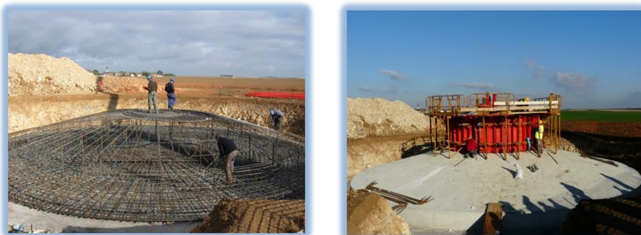
Figure 120 : Ferrailage et coulage des fondations
