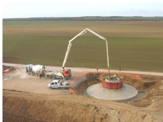
Emprise des fondations pendant les travaux Parc Eolien du Chemin d'Ablis – EDF Energies Nouvelles
