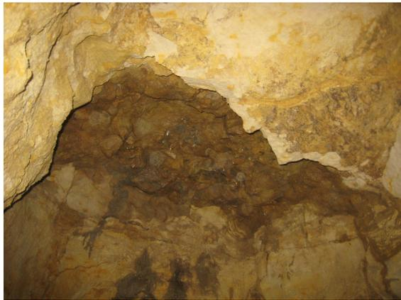
Figure 17 : Chutes de blocs « La Carrière »
