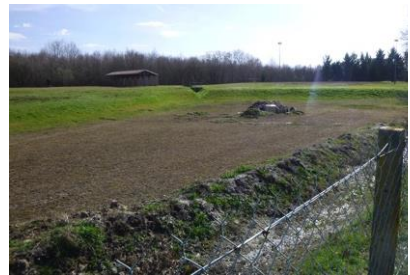
Lagune asséchée à l'Est
