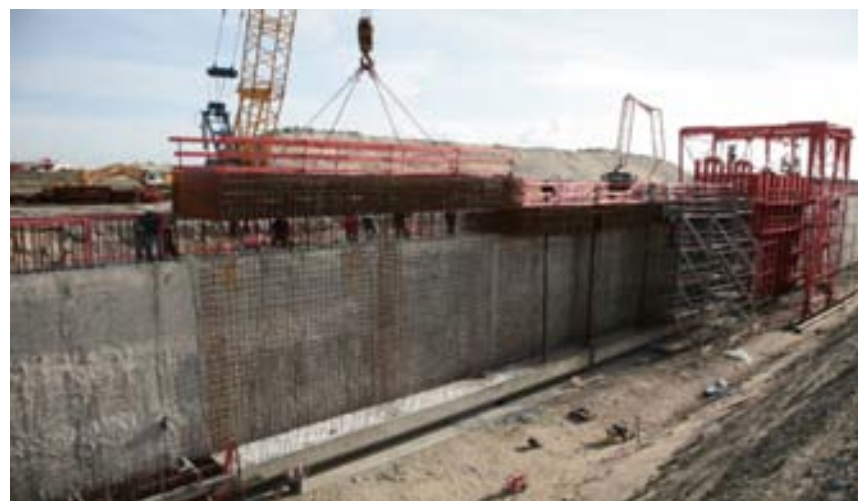
Vue lot A – exécution du génie civil voie avant
