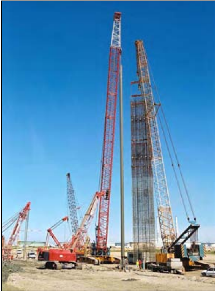
Positionnement des cages d'armature
