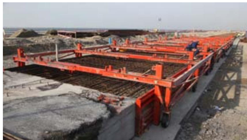
Vue lot A – exécution du génie civil voie arrière
