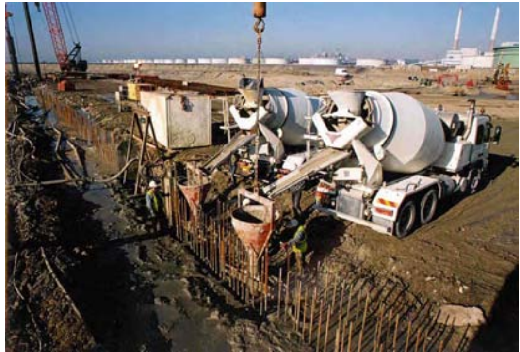
Bétonnage d'un panneau
