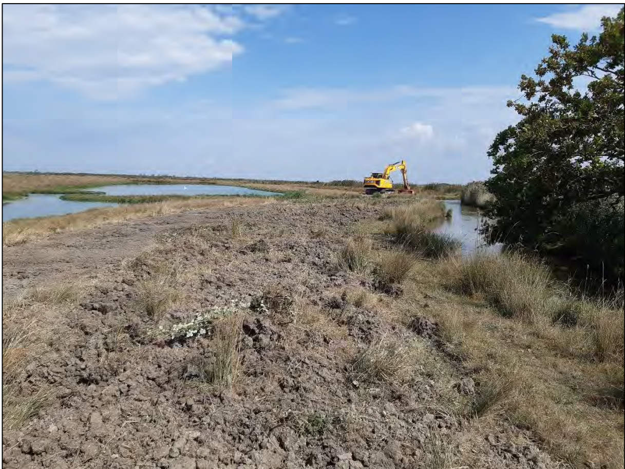
Photo 17 : Terrassement d'un ancien merlon de curage. © Rose Delacroix
