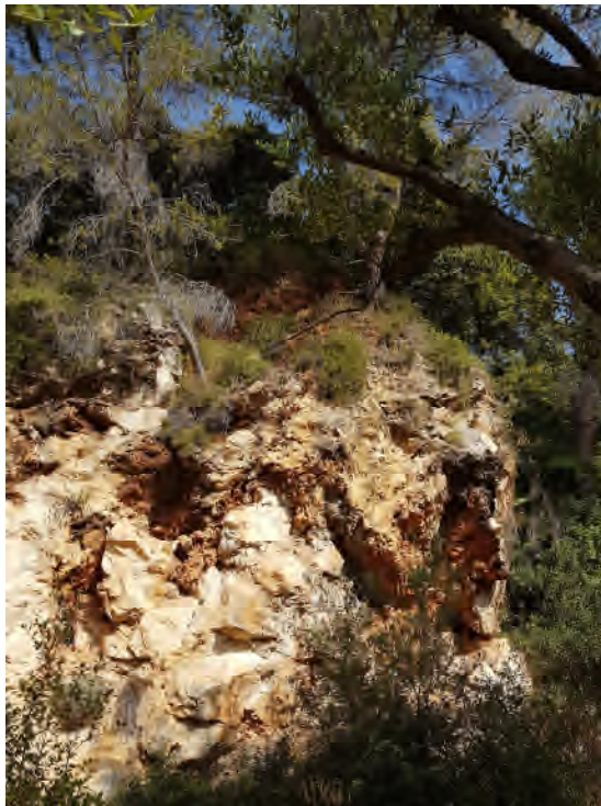
Figure 16 : photo de la falaise dans la zone 2, sur le coté Nord de l'entrée de la grotte (D). On observe des blocs largement fissurés.
