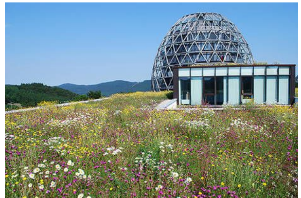
Toiture végétalisée – prairie naturelle
