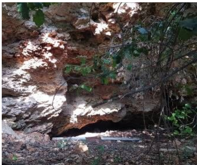
Photo zone soucavée en pied de falaise artificielle
