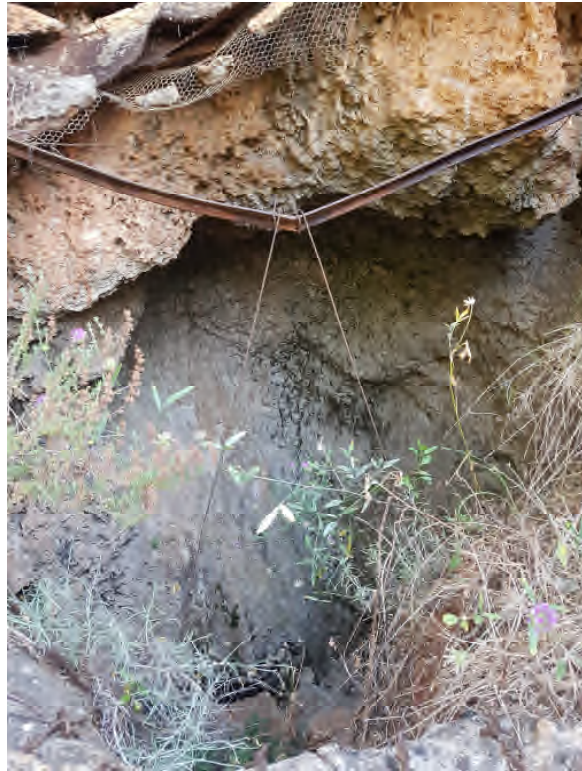
figure 11 : puits d'entrée vers une cavité non reconnue (A)
