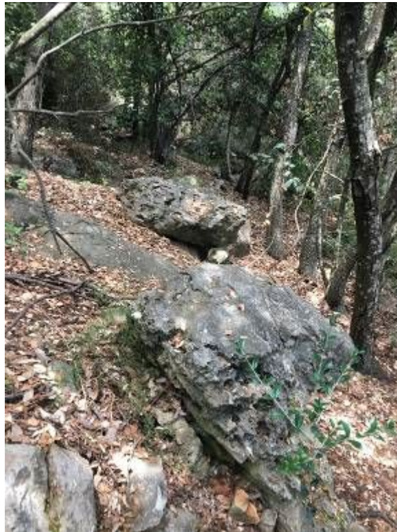
Photo : exemple de blocs éboulés sur les restanques en amont de l'ancienne carrière.
