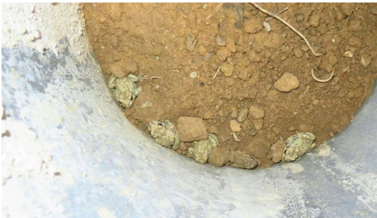
Exemple d'Amphibiens piégés dans un trou creusé sur un chantier
