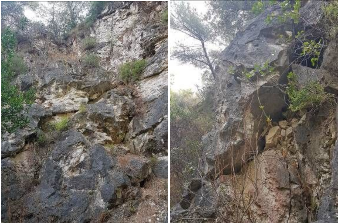
Détails de la zone effondrée formant un cône en pied de falaise
