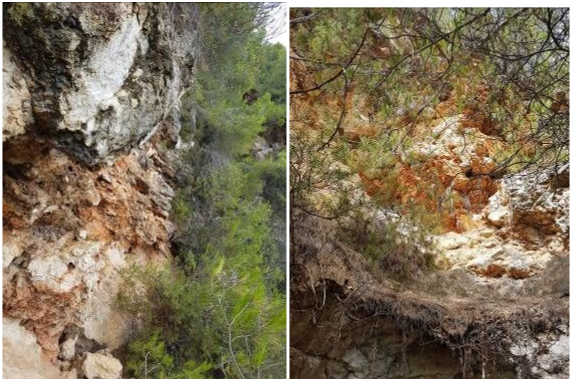
Photo de l'intérieur de la cavité avec zone d'effondrement en pied
