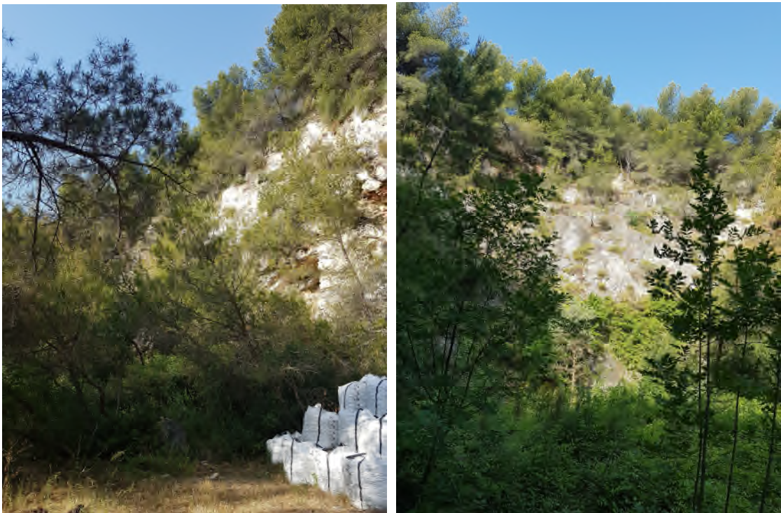
Figure 18 : photo de la falaise dans la zone 3, soulignant la hauteur de l'ordre de 30m surmontée par un talus fortement incliné envahi par une végétation dense et arbustive.
