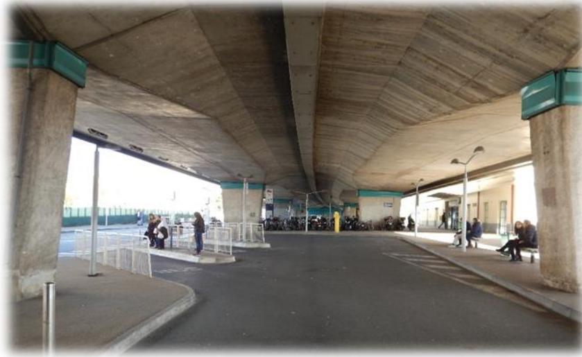
Photo 34 : Huit piles soutenant l'autoroute au droit de la gare (Systra, 2016)
