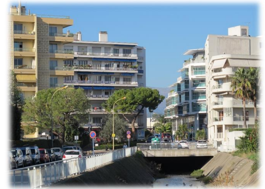
Photo 58 : La sortie du Malvan (Systra 2016)
