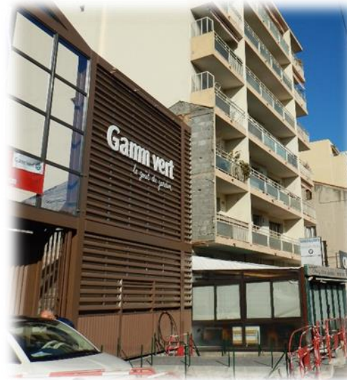
Photo 52 : La façade de la jardinerie côté autoroute (Systra 2016)
