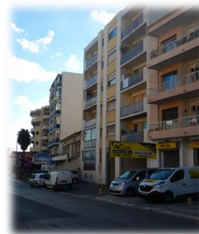
Photo 11 : Avenue de Grasse (Systra-2016)
