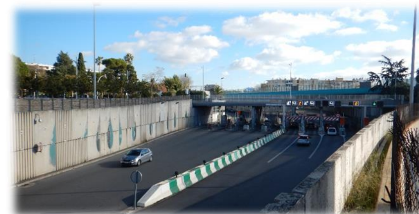
Photo 33 : Vue de l'avenue de la Gare traversant la barrière de péage de l'autoroute (Systra 2016)
