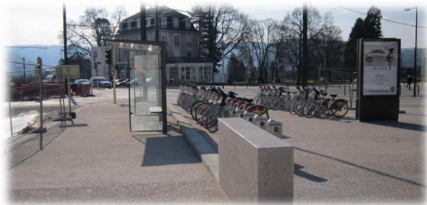
Photo 91 : Exemple de béton pour le parvis - gare de Besançon Viotte (AREP)
