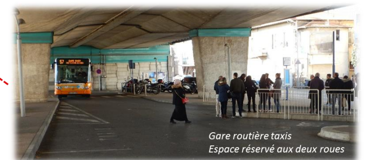
Figure 112 : Organisation de l'espace sous le viaduc autoroutier (Systra)
