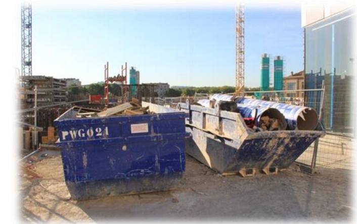
Photos 98 et 99 : Mise en place du tri sélectif sur un chantier urbain, source SYSTRA
