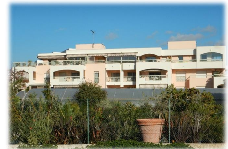
Photo 18 : Résidence collective (Systra-2016)
