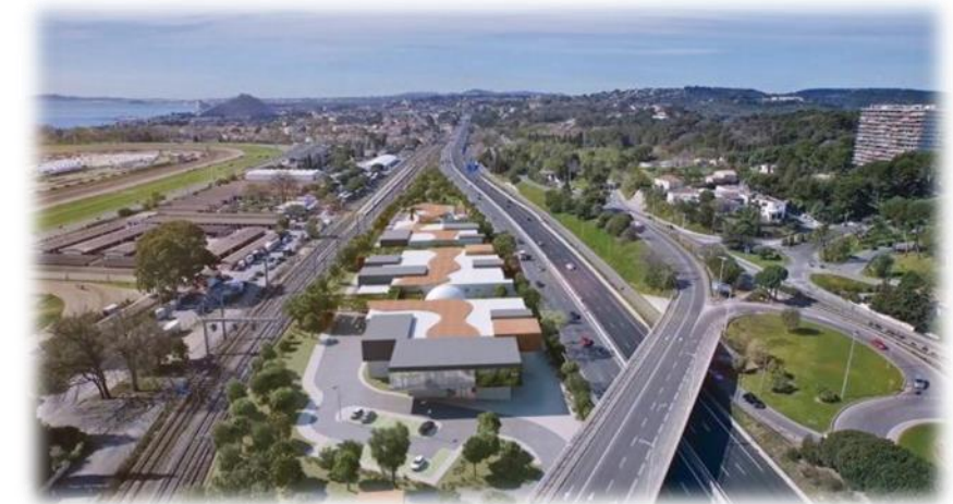
Figure 45 : Nouvelle station d'épuration de Cagnes-sur-Mer (MNCA)
