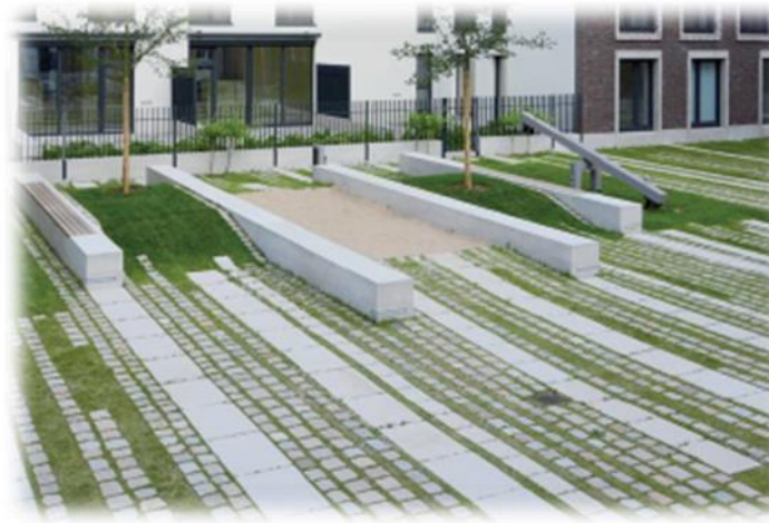
Photo 92 : Dalles et pavés enherbés - Katharinenquartier Hambourg (AREP)
