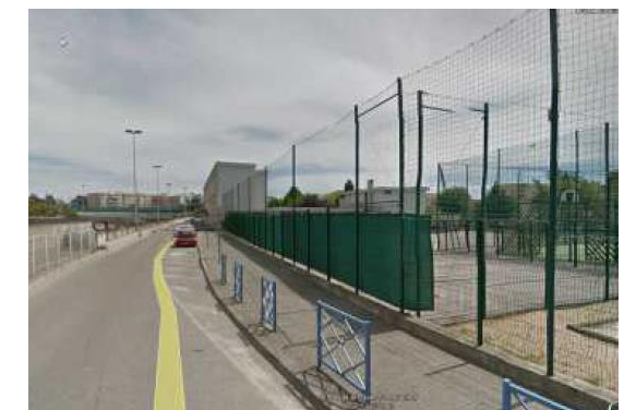
Photo 101 : Point d'entrée côté Autoroute (EGIS)
