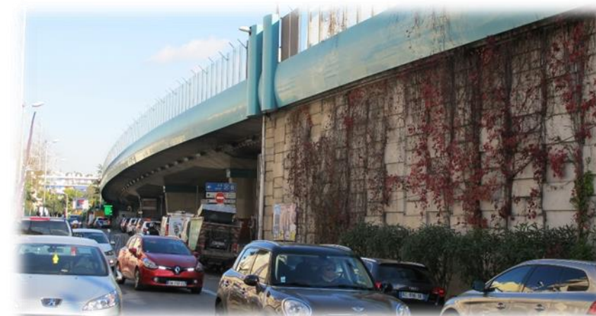
Photo 32 : Vue de l'A8 le long de l'avenue de la Gare (Systra 2016)
