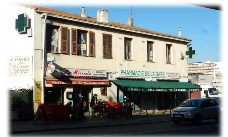
Photo 14 : Bâtiment en R+1 - Avenue de la Gare (Systra-2016)
