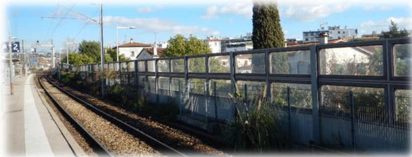
Photo 35 : Voie ferrée en gare de Cagnes-sur-Mer (Systra, 2016)
