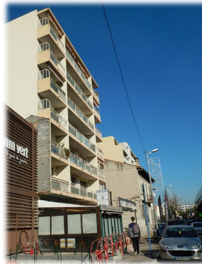
Photo 12 : Bâtiment en R+6 - Avenue de la Gare (Systra-2016)
