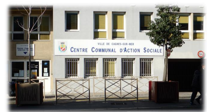
Photo 25 : Le CCAS, avenue de la Gare (Systra 2016)
