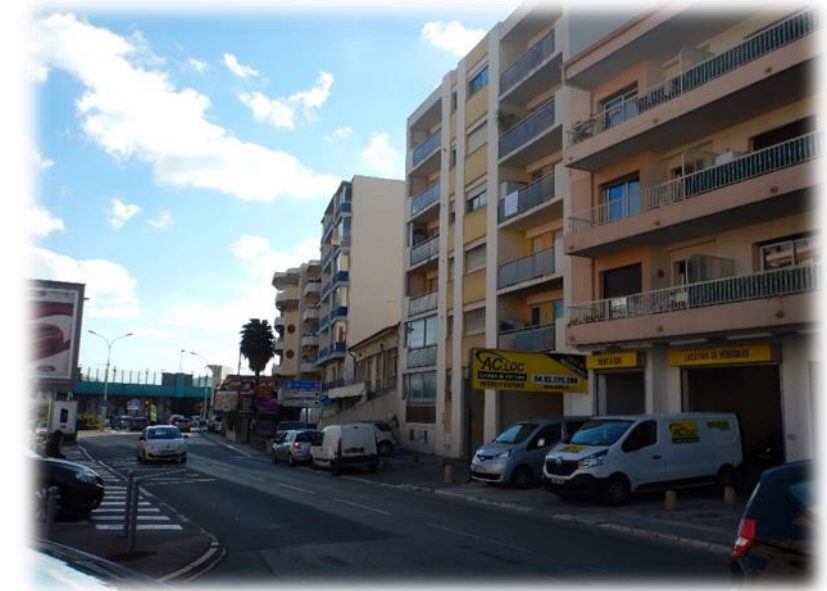
Photo 54 : L'avenue de Grasse donne directement accès à la gare (Systra 2016)
