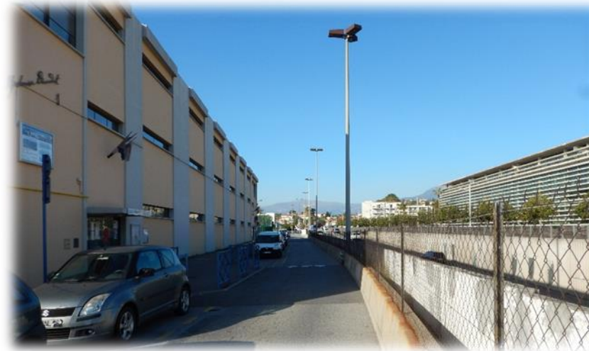
Photo 23 : Ecoles Alfonse Daudet 1 et 2 à gauche - Collège Jules Verne à droite (Systra 2016)
