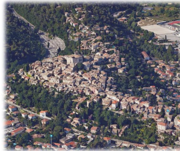
Figure 107: Vue du centre historique et des espaces naturels qui le dessinent (AREP)
