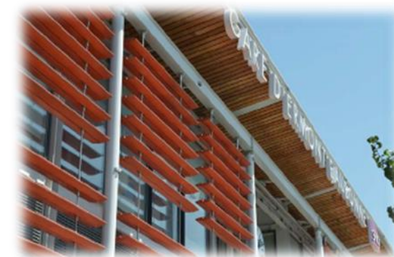
Figure 150 Exemple de traitement en façade en terre cuite sur la gare de Clermont-Ferrand (AREP)
