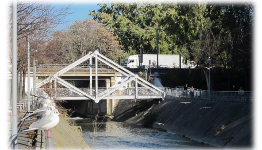
Photo 59 : La passerelle sur la Cagne (Systra 2016)
