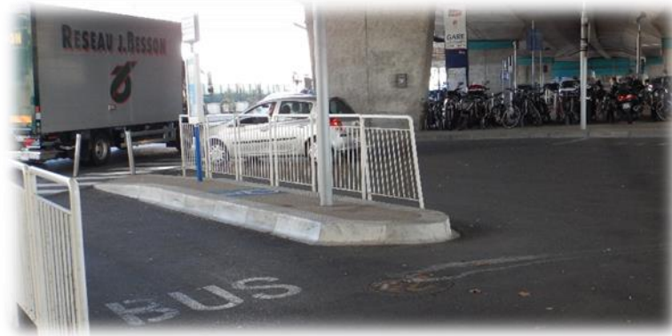
Photo 36 : Arrêt de la Gare SNCF sous l'autoroute A8 - A droite, la présence de quais ferroviaires (Systra, 2016)
