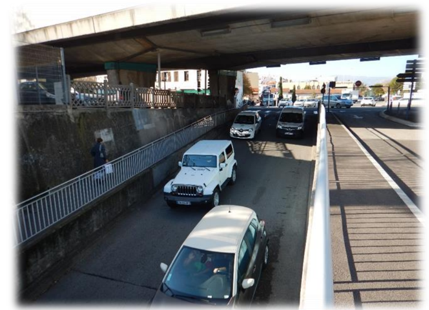
Photo 83 : Rue Garigliano (Systra 2016)
