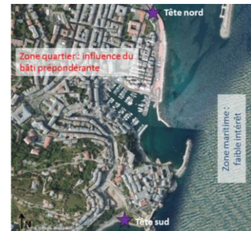
Bâti autour de l'ouvrage (Google Earth)
