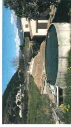
A titre d'exemple, 4 réservoirs situés dans la partie sud-est du site pourraient être alimentés gravitairement par la une noue à réaliser à proximité. Le volume de ces 4 réservoirs est estimé à 260m<sup>3</sup>. Ce volume de 260 m<sup>3</sup> permettrait d'arroser 2 fois par semaine, pendant les 2 mois les plus chauds, 3 200m<sup>2</sup> d'espace vert.
