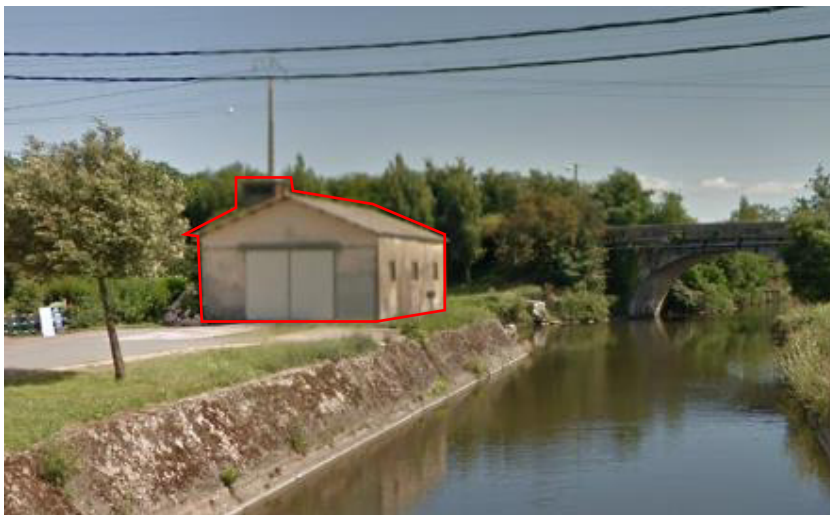
Etat actuel du bâtiment à détruire au niveau du Pont de paille (en rouge sur le plan)
