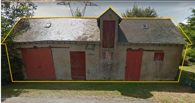
Etat actuel du bâtiment à détruire rue A. Berselli (en jaune sur le plan)
