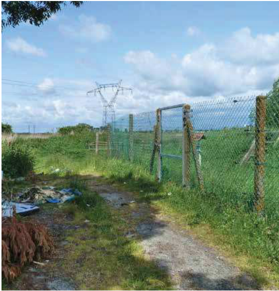
oléoduc- photo de l'existant
