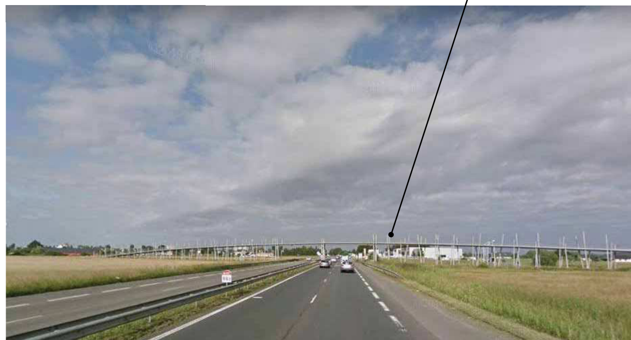
Passerelle de la piste cyclable - photo de l'existant
