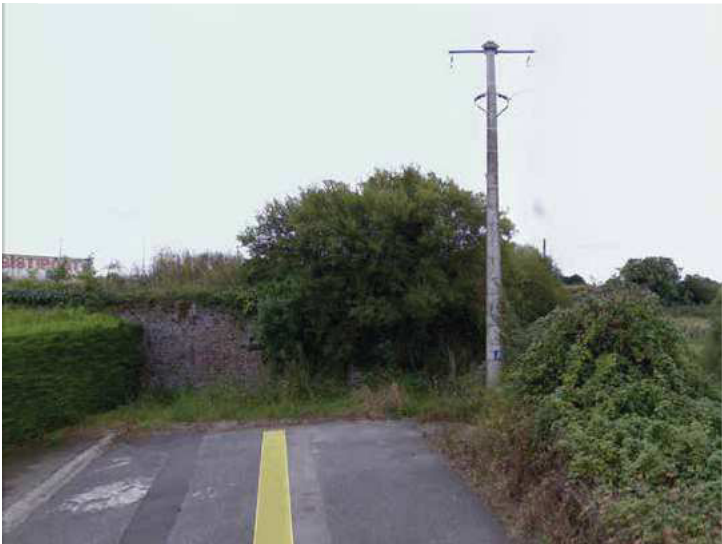
Mur de soutènement - photo de l'existant
