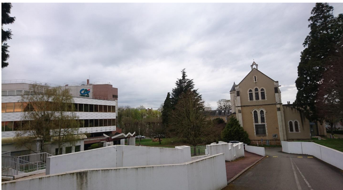
Photographie de l'arrière de la chapelle (façade Est)
