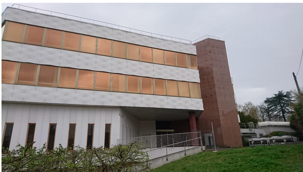
Photographie du terrain (façade Nord-Ouest)
