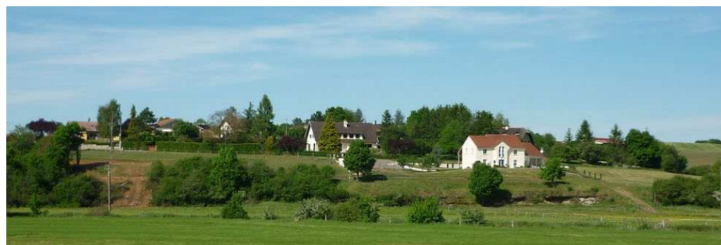
Soulosse-sous-Saint-Elophé / rue de la Roche Jeannotte : une maison en mode ostentatoire qui impacte les vues offertes depuis la RD3. La maison voisine sur la gauche, pourtant plus haute, est beaucoup moins prégnante, du fait de sa forme et de la nature de ses abords.
