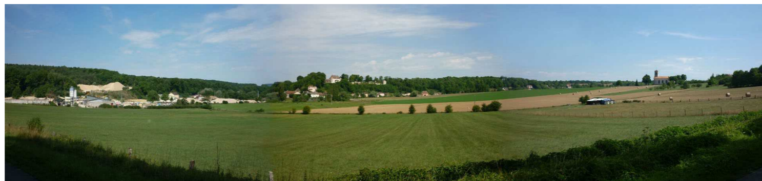
Vue depuis la RD3e : les installations Calin exercent un impact fort dans les vues de la vallée, en covisibilité avec les deux édifices majeurs. Un dispositif d'insertion pourrait être ménagé au moyen par exemple d'une simple structure arborée en limite de la zone d'activités.
