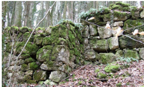
Vestiges d'ouvrages localisés sur le haut du coteau au sud-ouest du village de Domremy, au sud du cimetière, dans un environnement aujourd'hui boisé. L'origine celtique est évoquée mais il s'agirait plutôt de constructions beaucoup plus récentes liées à l'activité viticole, puisque la vigne dominait ce secteur jusqu'au début du XXe s (cf. plan Jollois page précédente). (photo : domrémylapucelle.leclosdomrémy.fr)
