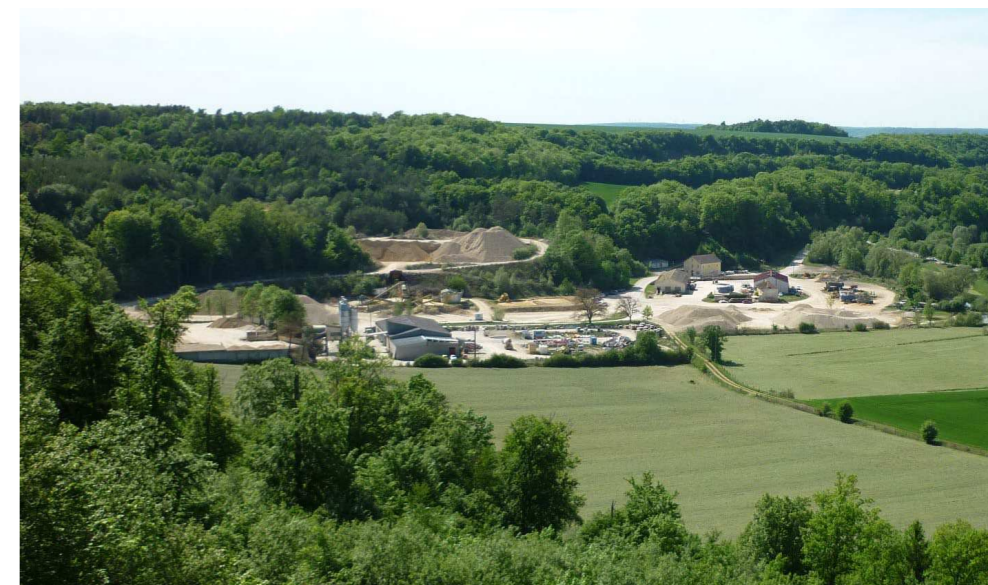
Carrière du Chatelet (Barville) : il s'agit en réalité d'une installation classée de criblage et stockage de matériaux, installée au pied d'une ancienne carrière. Malgré sa situation lovée dans un méandre de la vallée du Vair, cet ensemble présente de forts impacts visuels notamment en covisibilité avec le site médiéval d'Harchéchamp et l'église de Barville.
