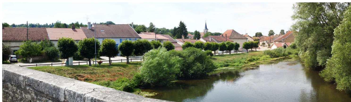
Le bord de Meuse et son petit quartier «faubourg» remarquable.
