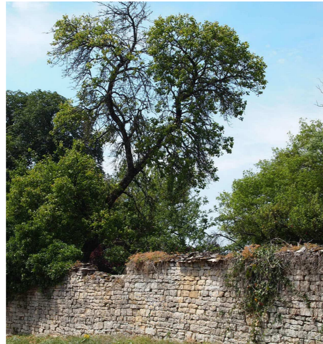
La roche locale mise en oeuvre sous forme de moellons de construction, expression façonnée du substrat géologique (Murs à Moncel).
