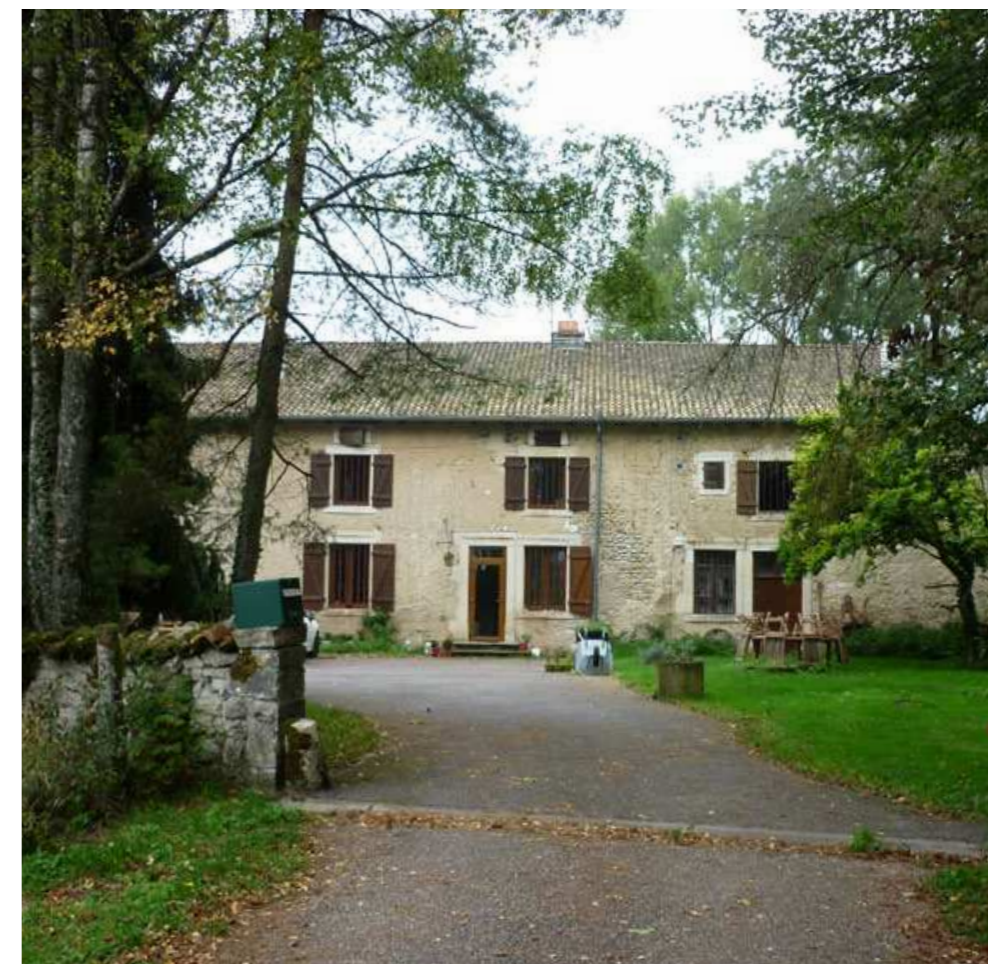
Moulin de Greux, au coeur du vallon du ruisseau des Roises.
