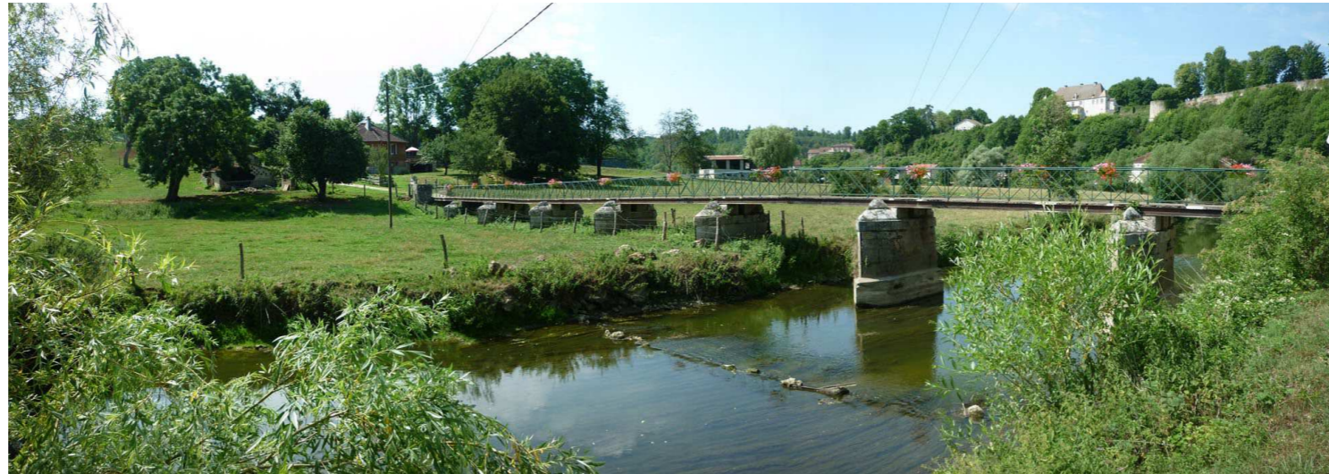
Bords du Vair à Harchéchamp : la passerelle métallique permet de rejoindre directement l'église de Barville et son belvédère en traversant des prairies et des jardins bucoliques. En arrière-plan, la forteresse d'Harchéchamp domine la vallée.
