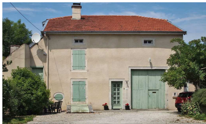
Maison rurale rénovée à Saint-Élophé.
