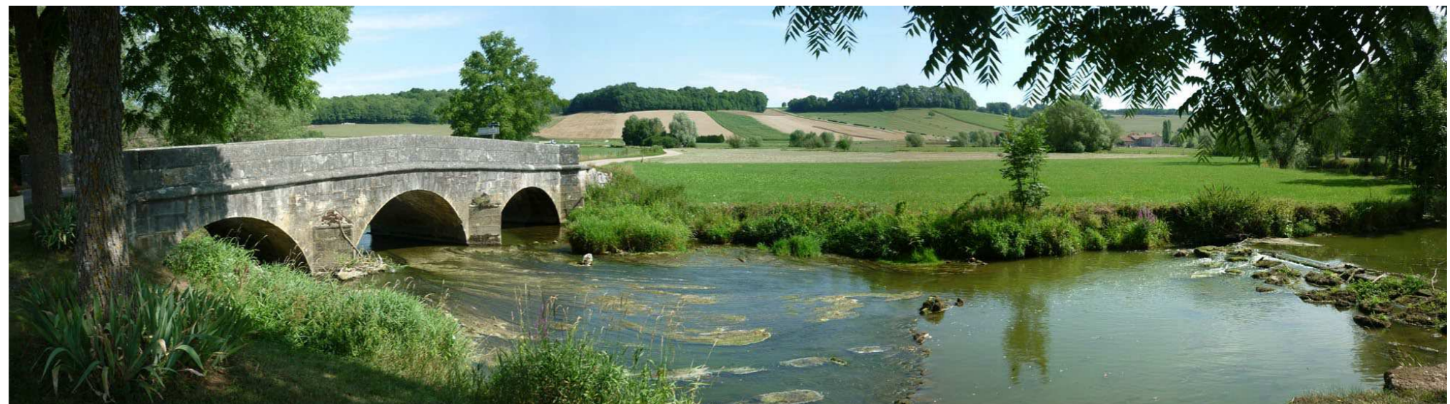
Pont sur le Vair à Barville.
