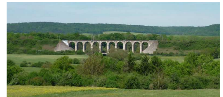
Viaduc de Soulosse.
