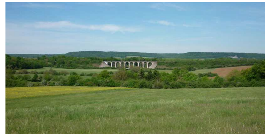
Le viaduc de Soulosse (vu depuis Gouécourt, en covisibilité avec la Basilique) est un très bel ouvrage de la ligne Toul-Neufchâteau, qui traverse une séquence naturelle de la vallée du Vair. Il est accessible depuis la RD3 avec un cheminement piéton intégré dans l'ouvrage.
