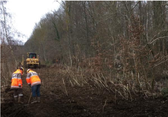
Travaux préparatoires (défrichage/nivellement)
