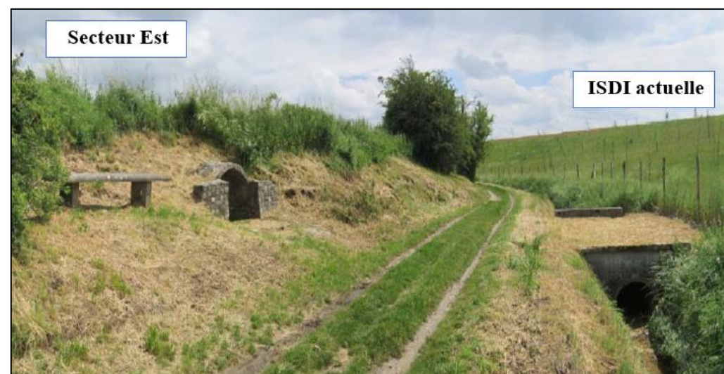
Figure 8 : Photo montrant le profil d'aménagement de la coulée verte permettant de redresser la topographie des terrains agricoles
