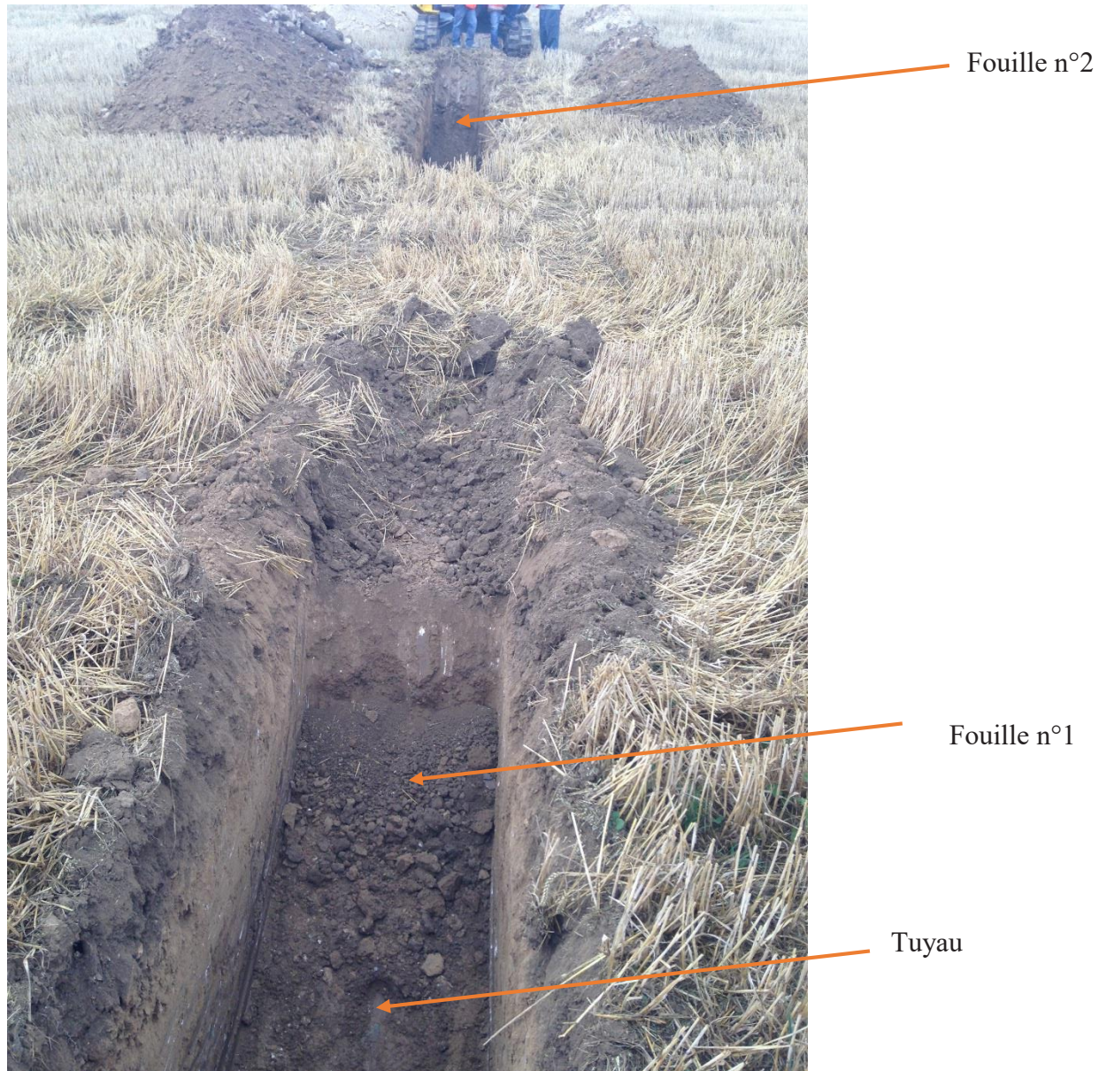
Figure 2, Fouilles 1 et 2 et détection du tuyau
