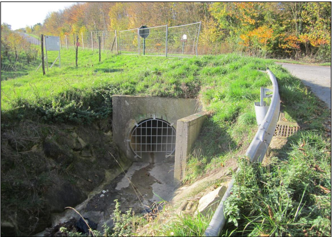
Figure 15: Ouvrage de collecte des eaux pluviales à l'amont du fossé, chemin de la fontaine Sainte-Geneviève
