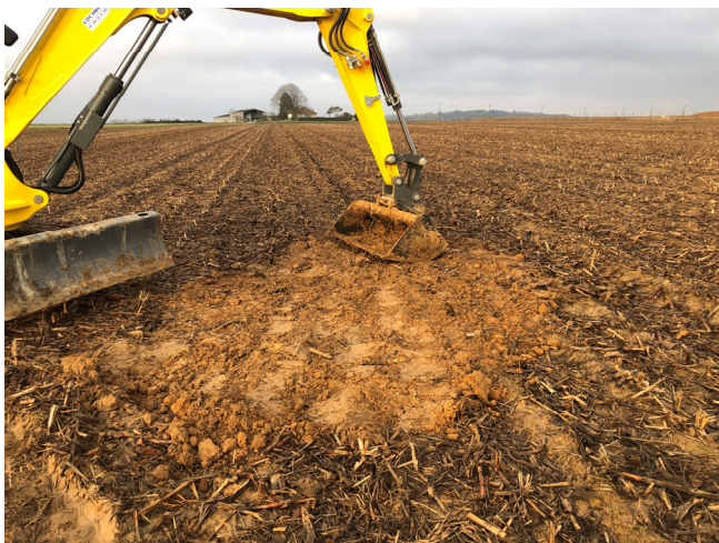
Rebouchage de la plate-forme (essai 3).
