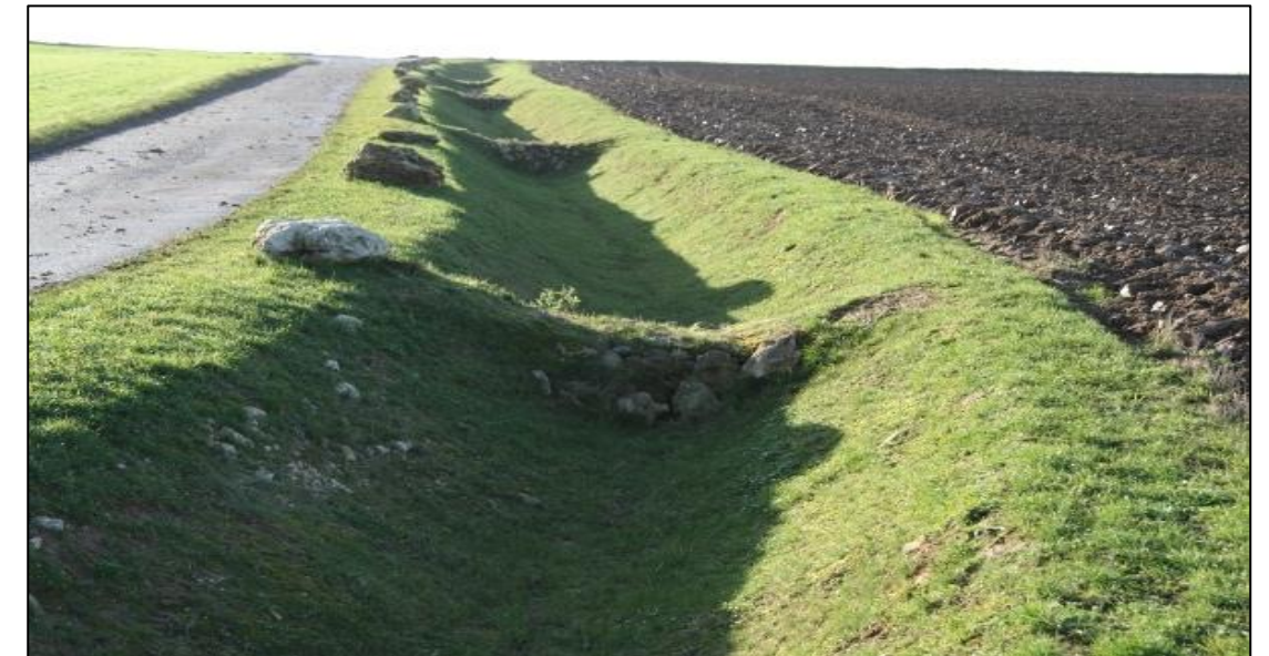
Figure 47 : Exemple de mise en œuvre de la technique des seuils de rétention (source COSSON)
