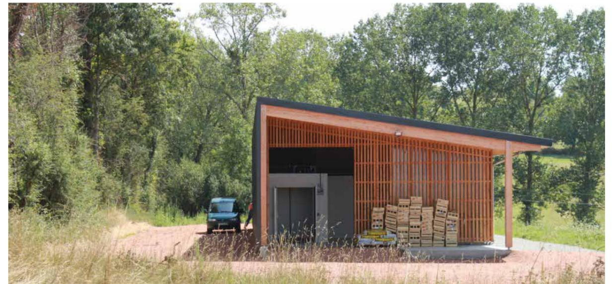
Une construction épurée mais singulière en ossature et charpente bois, enveloppée sur le toit à pente unique et en façade nord par un seul et même revêtement, très discret dans le paysage.
