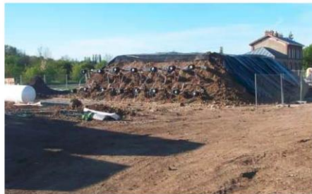
Photographie d'une pile de traitement par désorption thermique sur site
