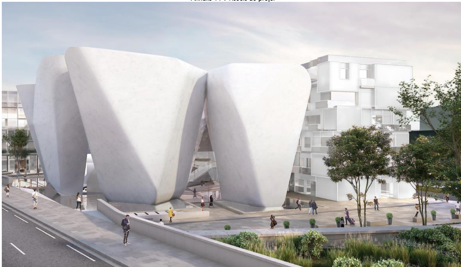
Vue depuis le Boulevard Foulques Nerra
