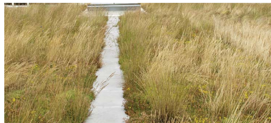
Toiture semi-extensive : végétation herbacée
