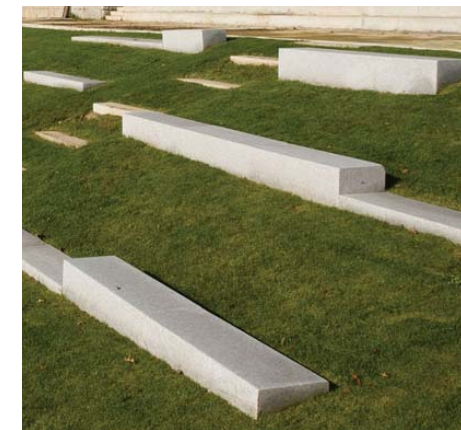
Gradines au sein de talus végétalisés
