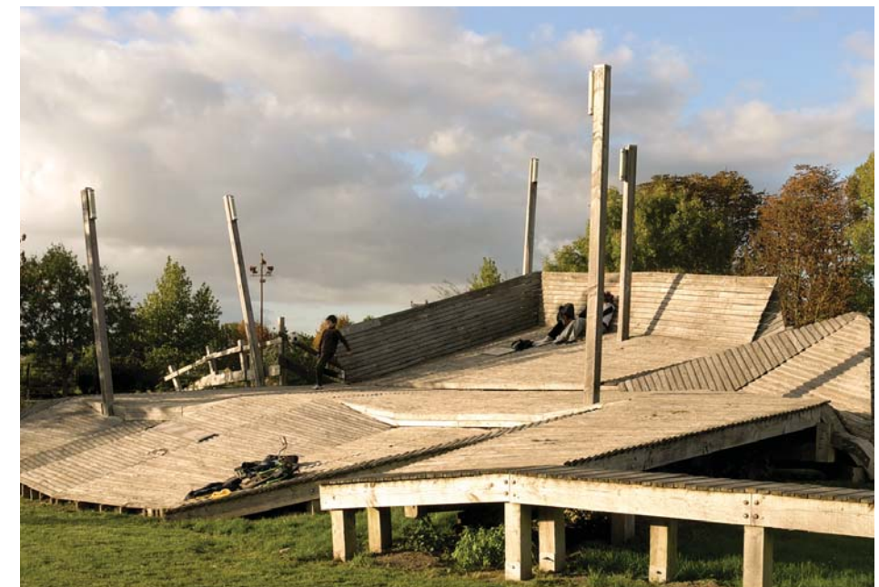
Structure solarium bois _ BASE _ Chapelle Saint-Luc
