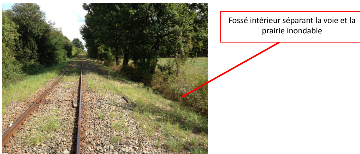
Figure 12 : prairie inondable (zone de frayère potentielle) adjacente à la voie ferrée. Le fossé intérieur peut se retrouver sous la même ligne d'eau que la prairie en périodes d'inondations (Source Simethis)
