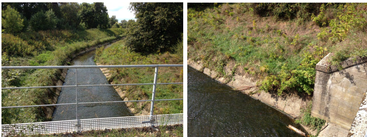
Figure 10 : Exemple d'absence d'exutoire direct ou d'ouvrage de régulation au niveau du franchissement de l'Estey du Guâ (Source Simethis)
