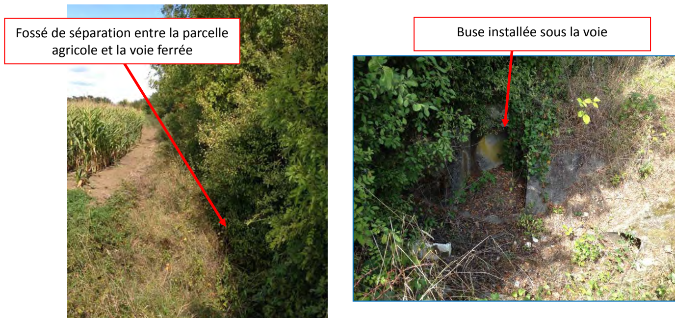
Figure 11 : Exemples de connexion entre une parcelle agricole et la voie ferrée. Le passage busé (photo de droite) permet la libre circulation de l'eau de part et d'autre de la voie (Source Simethis)
