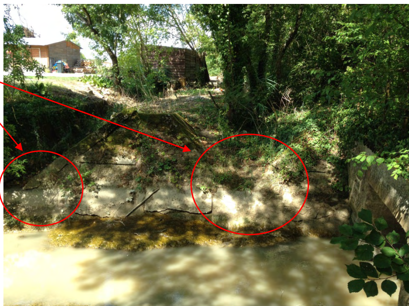
Figure 9 : Certains fossés n'ont pas d'ouvrage de régulation en sortie. La photo du haut montre qu'une buse située au-dessus de l'estey correspond à l'exutoire du fossé intérieur de la voie. En bas, la photo montre l'exutoire de deux fossés de la voie. (Source Simethis)
