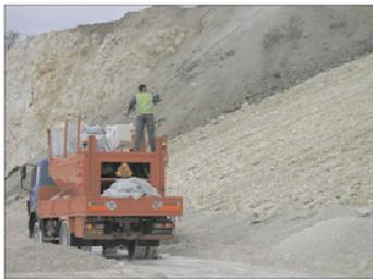
Opération d'hydroseeding en œuvre : pulvérisation sous pression de grains arrosés d'une pâte de cellulose humide
