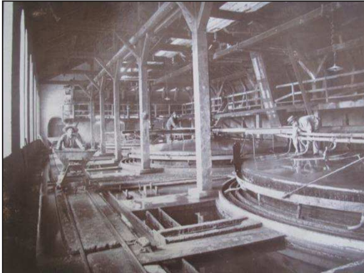
Figure 8: Photographie des tables de Likenbach dans la grande laverie de Chaliac
