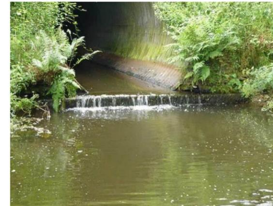
La luminosité est correcte. Si le calage de la buse permet de maintenir une lame d'eau suffisante, même en étiage, **les seuils aval et amont présentent des difficultés de franchissement en période de faibles débits**, aussi bien pour les remontées que pour les avalaisons. **En revanche, pour des débits plus élevés, les seuils doivent « s'effacer » totalement et l'ouvrage doit être transparent pour la circulation.**
