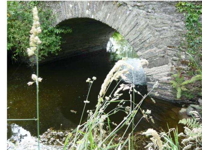
2. sous la RN164, un ouvrage composite très long (environ 50 m). D'aval en amont, on trouve une buse béton de Ø 2000, d'une longueur d'environ 35 m, puis un ancien ouvrage à voûte maçonnée, de 1,9 m de large pour 1,7 m de flèche, qui forme un coude avec la buse. Le radier est de type galet cloué au béton. Entre les deux, il existe une chute d'environ 30 cm.
