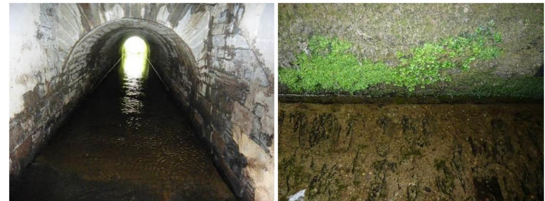
Dès l'entrée dans la buse, il y a mise en vitesse et formation d'un jet. Puis, vers l'aval, du fait du niveau d'eau élevé de l'Aulne canalisée, la hauteur d'eau passe de 5 cm à plus de 40 cm et le courant devient nul.
