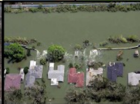
London Ave. Canal Breach
