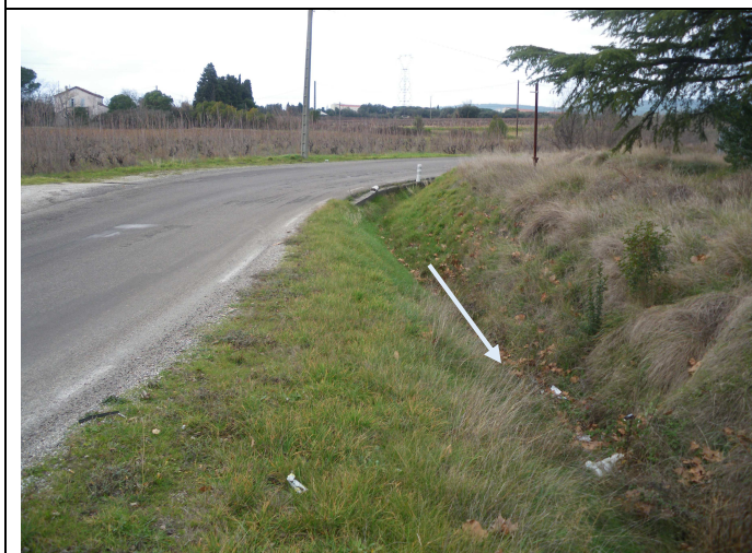
Photo 5 : Fossé pluvial route de la gare
