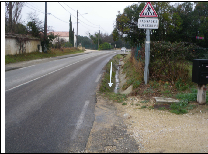
Photo 2 : Fossé pluvial RD9
