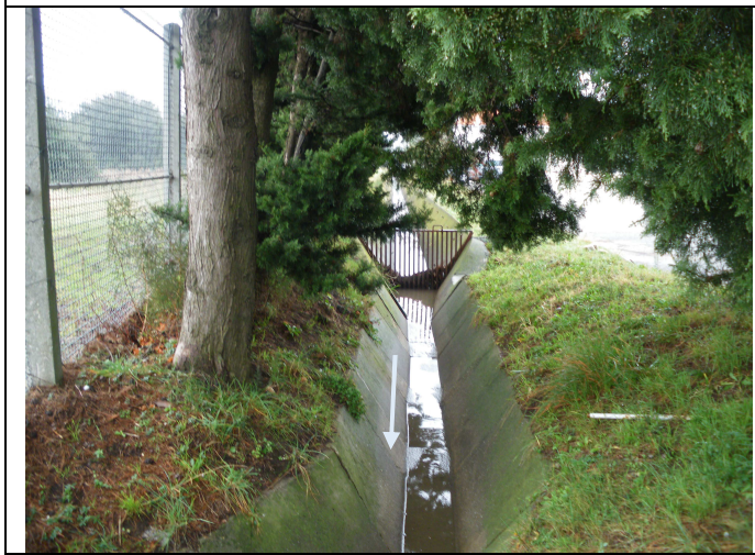
Photo 3 : Fossé pluvial béton caserne
