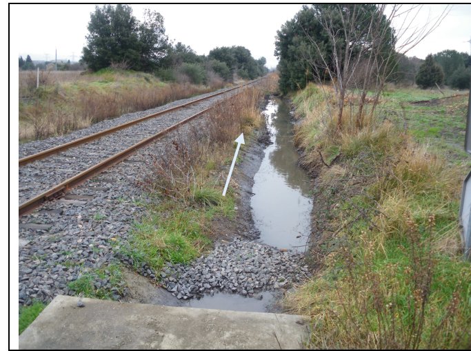
Photo 7 : Fossé pluvial voie ferrée
