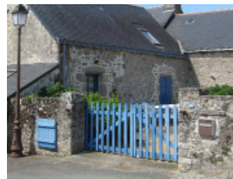
Maintien des portails à barroyage en bois - peint dans la même teinte que les menuiseries de la façade
