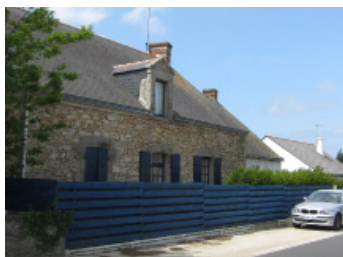
Des clôtures en rupture
