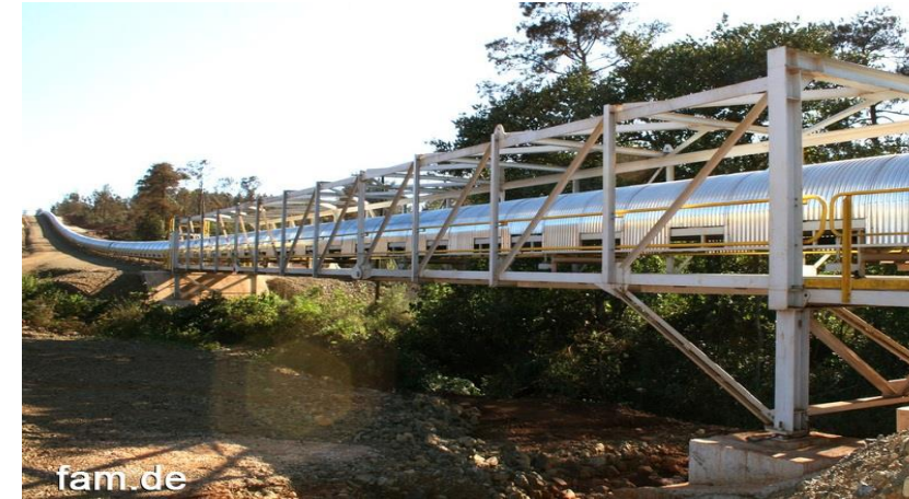
Convoyeur sur poutre pour franchissement d'obstacle
