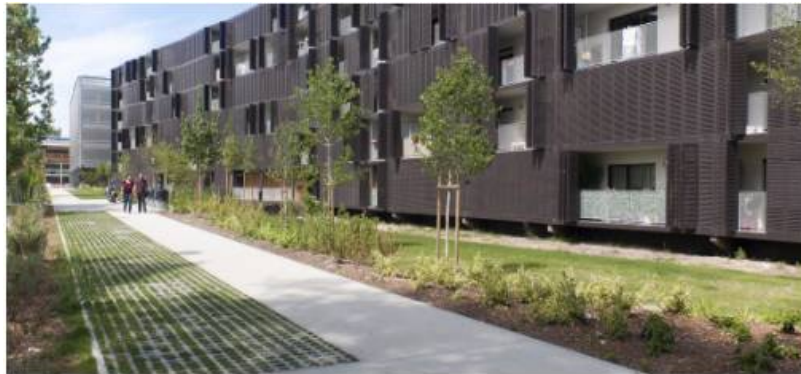
Photo 3 : Exemple d'une allée en béton et de surlageur en dalles béton perforées et joints engazonnés (Source : étude paysagère)
