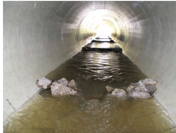
Photo 30 : Aménagement de micro seuil dans un ouvrage hydraulique (source P. Poublan)
