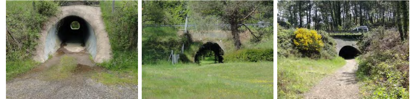
Photo 21 : Les trois passages agricoles sous l'autoroute existante (Source : Setec, mai 2012)
