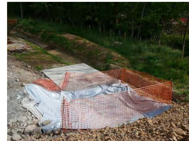
Photo 25 : Bassin imperméabilisé de récupération des laitances de béton (Source : Setec - A89)
