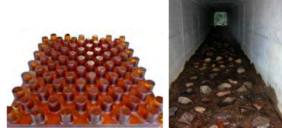
Photo 26 : Aménagements possibles pour la transparence de l'Anguille (guide SETRA)
