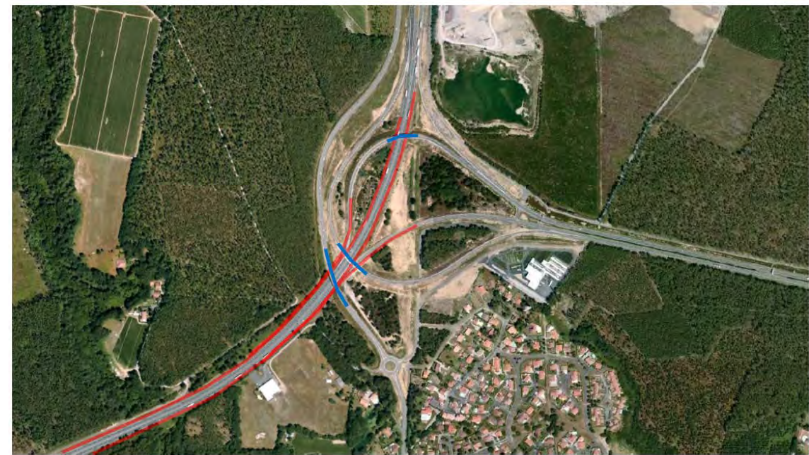
Figure 8 : Vue aérienne du diffuseur de Saint-Geours-de-Maremne
