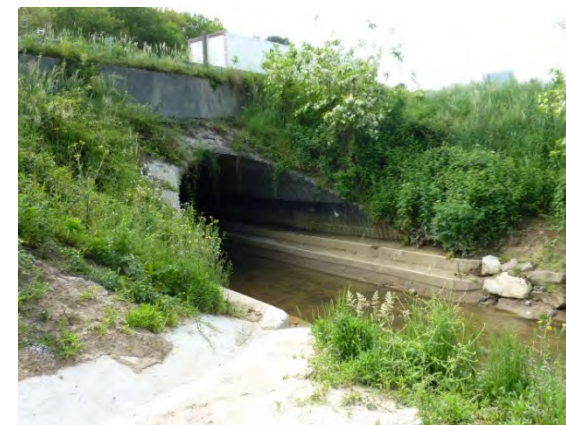
OH 390 Aval – Avec banquettes pour passage faune
