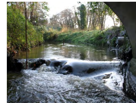
Photo 28 : Seuil amont du ruisseau du Moulin de Lamothe à supprimer (source P. Poublan)
