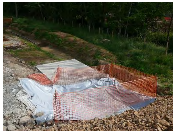
Photo 16 : Bassin imperméabilisé de récupération des laitances de béton (Source : Setec - A89)
