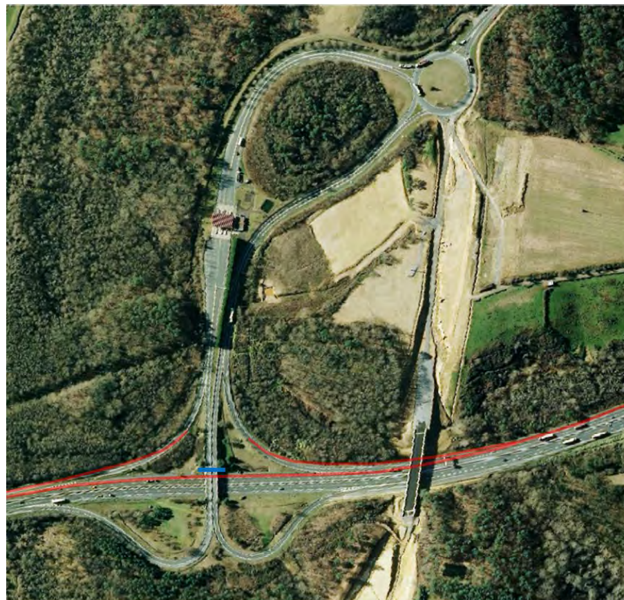
Figure 4 : Vue aérienne du diffuseur d'Ondres
