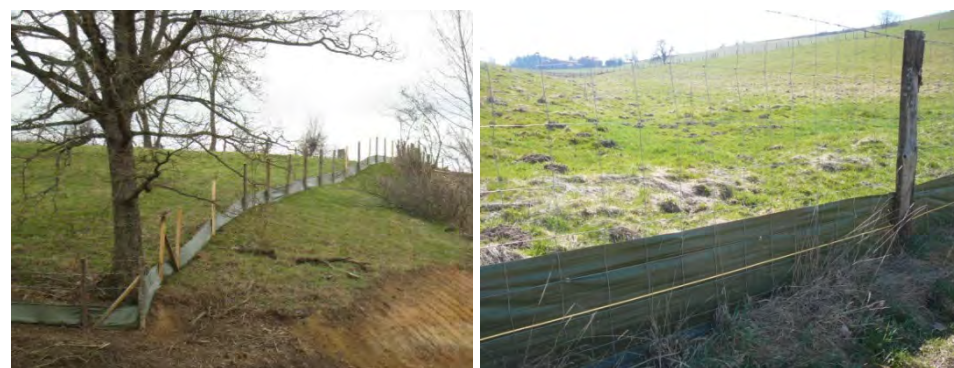
Photo 31 : Mise en place de « bâches amphibiens » en phase travaux (Source : A89, SETEC)
