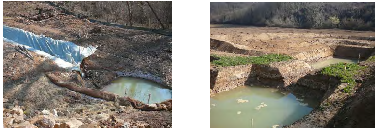
Photo 15 : Bassins provisoires (Source : Setec - A89)
