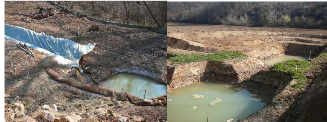
Photo 24 : Bassins provisoires (Source : Setec - A89)
