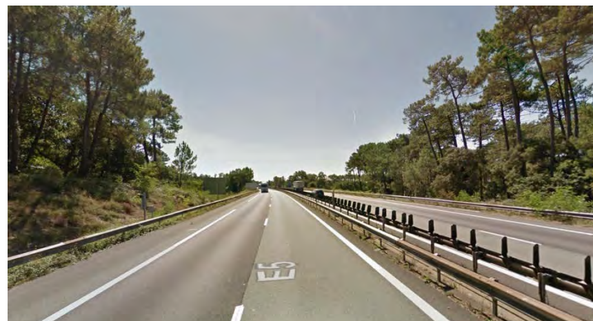
Photo 22 : Bords de l'autoroute à Labenne (source : Googlemaps)
