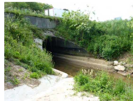
OH 390 Aval – Avec banquettes pour passage faune
