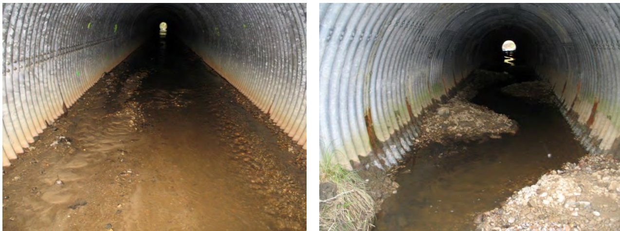
Photo 27 : Illustrations de la mise en place de déflecteurs à l'intérieur d'un ouvrage hydraulique (source : P. Poublan)
