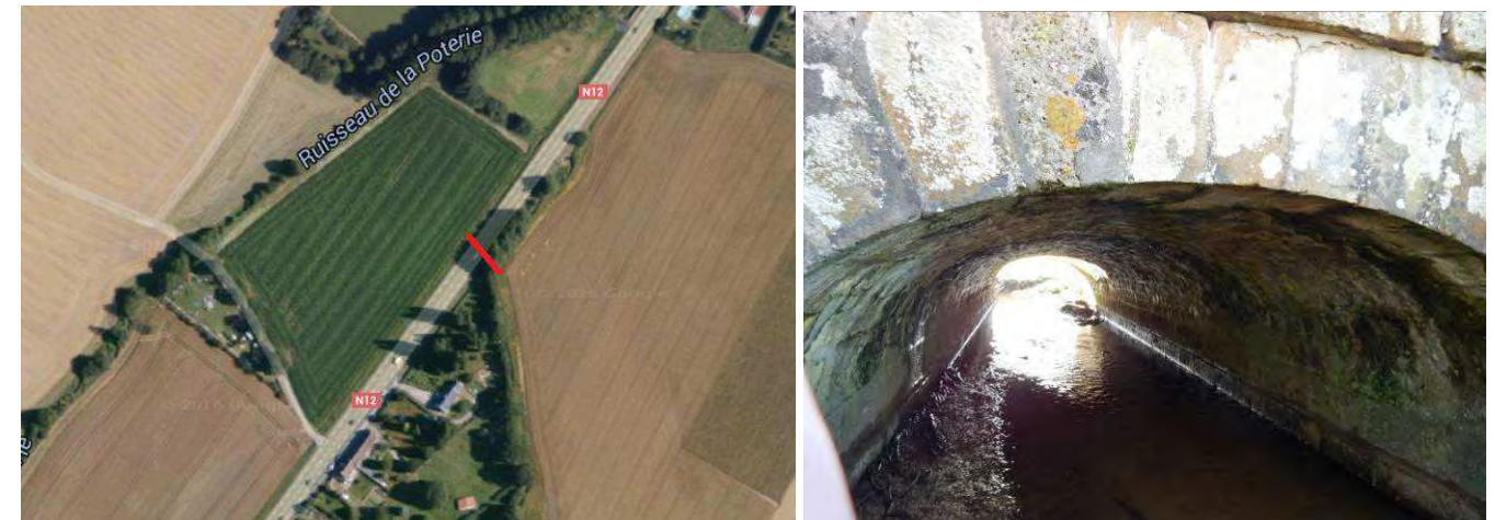
Illustration 28 : Ouvrage hydraulique du ruisseau de Charencey (source : Google Earth / Google streetview / SEGIC)
