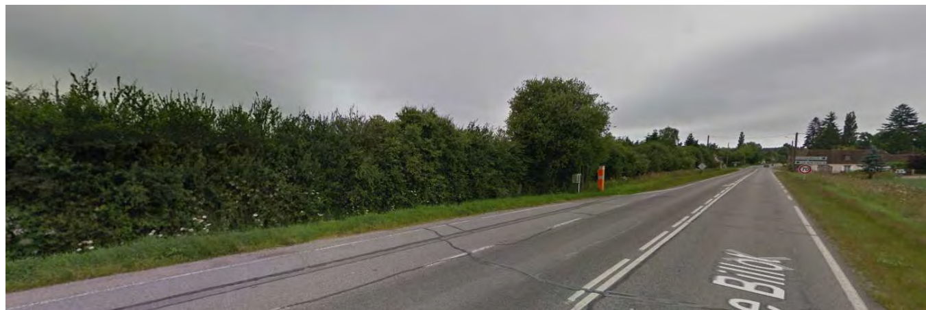
Illustration 128 : Poste d'appel d'urgence du PR 10+000 (source: Google streetview)
