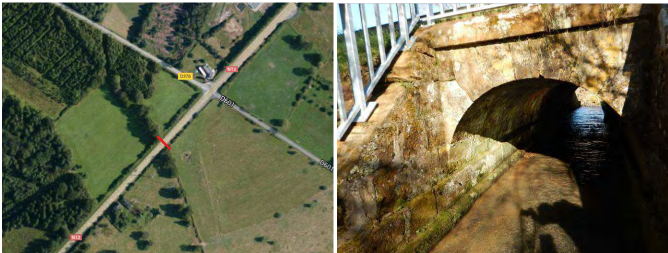
Illustration 26 : Ouvrage hydraulique de l'affluent du ruisseau de la poterie (source : Google Earth / Google streetview / SEGIC)
