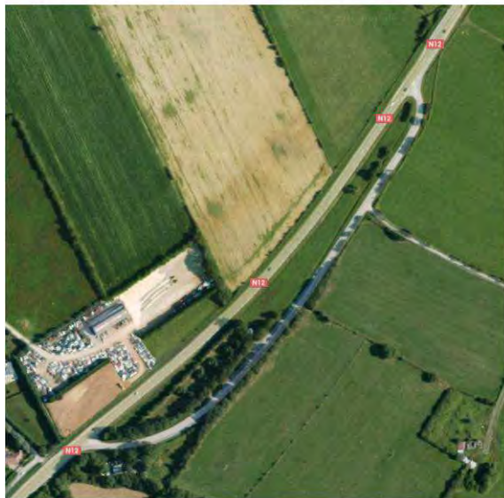
Illustration 125 : Aire de repos de « La Mallière » (source: Google streetview / Google earth)
