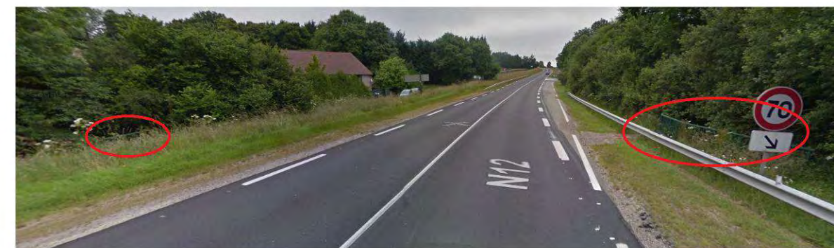
Illustration 24 : Ouvrage hydraulique de « La Jambée » (source : Google earth / Google streetview / SEGIC)
