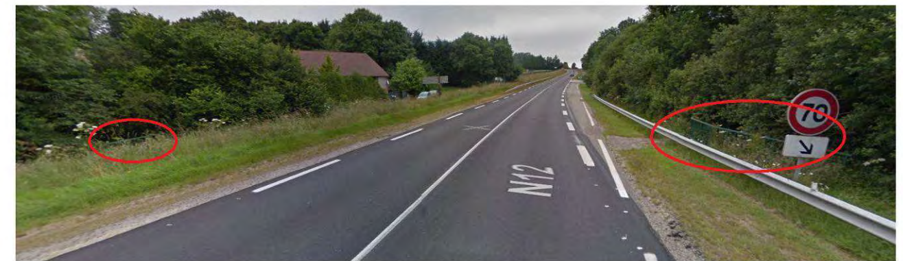
Illustration 126 : Ouvrage hydraulique de « La Jambée » (source: Google streetview / Google earth / SEGIC)
