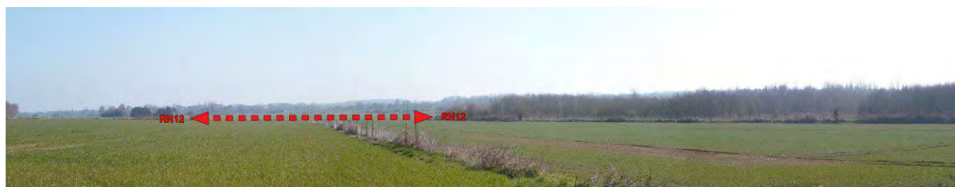
Illustration 59 : Vue de la RN12 depuis le lieu-dit « Le Parc »
