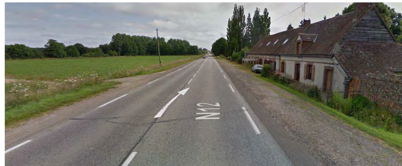
Illustration 143 : Photo de la traversée du lieu-dit « Le Gué Hamel » (source: Google streetview)
