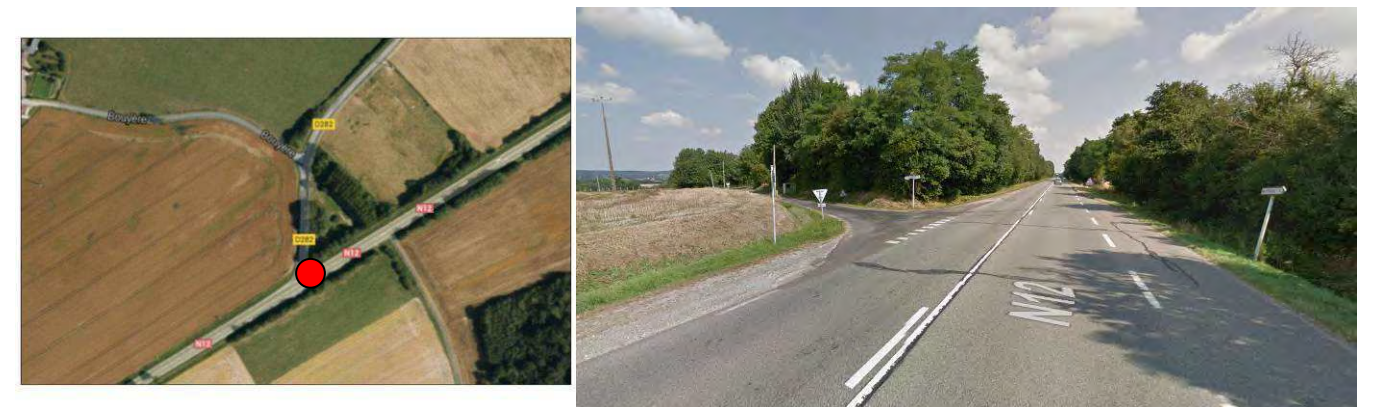
Illustration 108 : Carrefour avec la RD 282 Nord (source: Google earth / Google Streetview)
