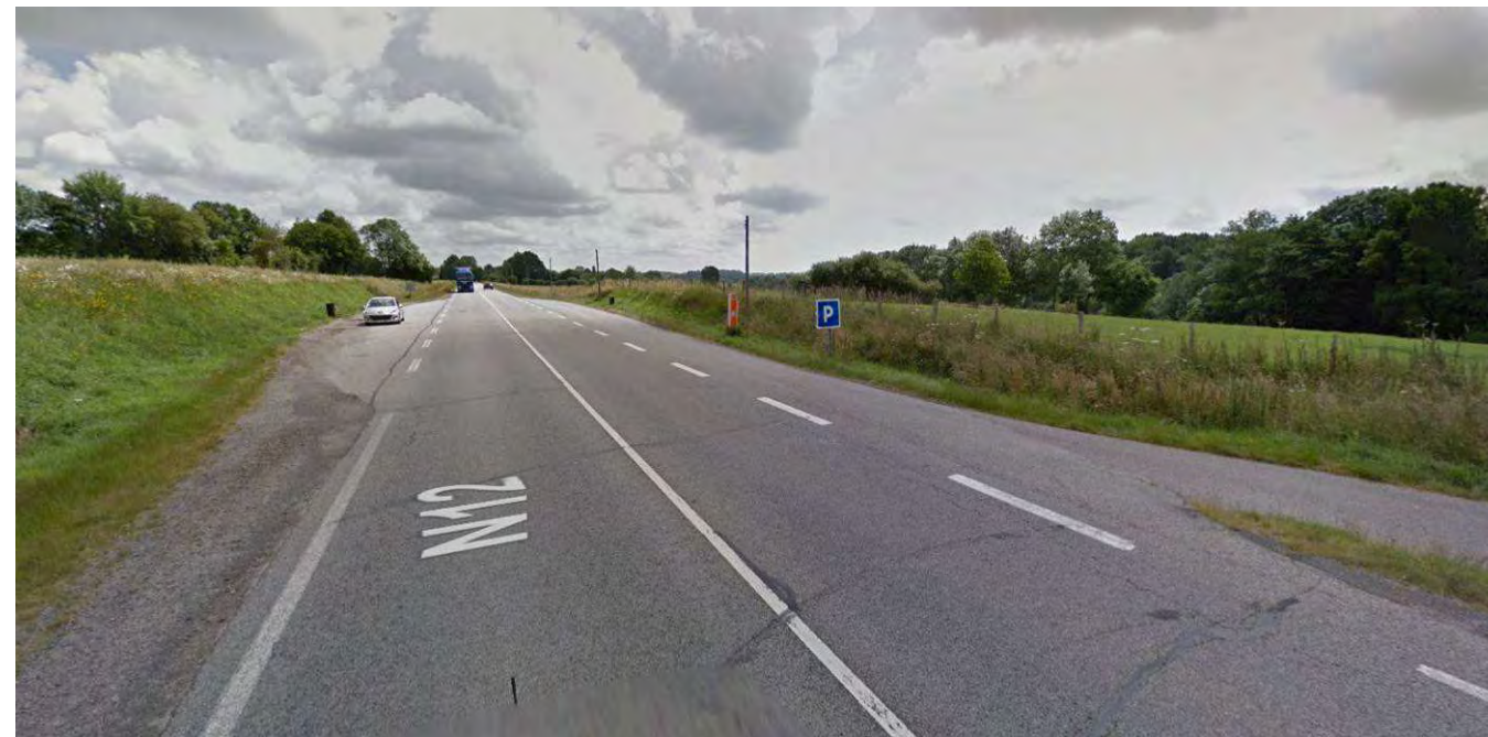
Illustration 123 : Poste d'appel d'urgence du PR 18+300 (source: Google Streetview)
