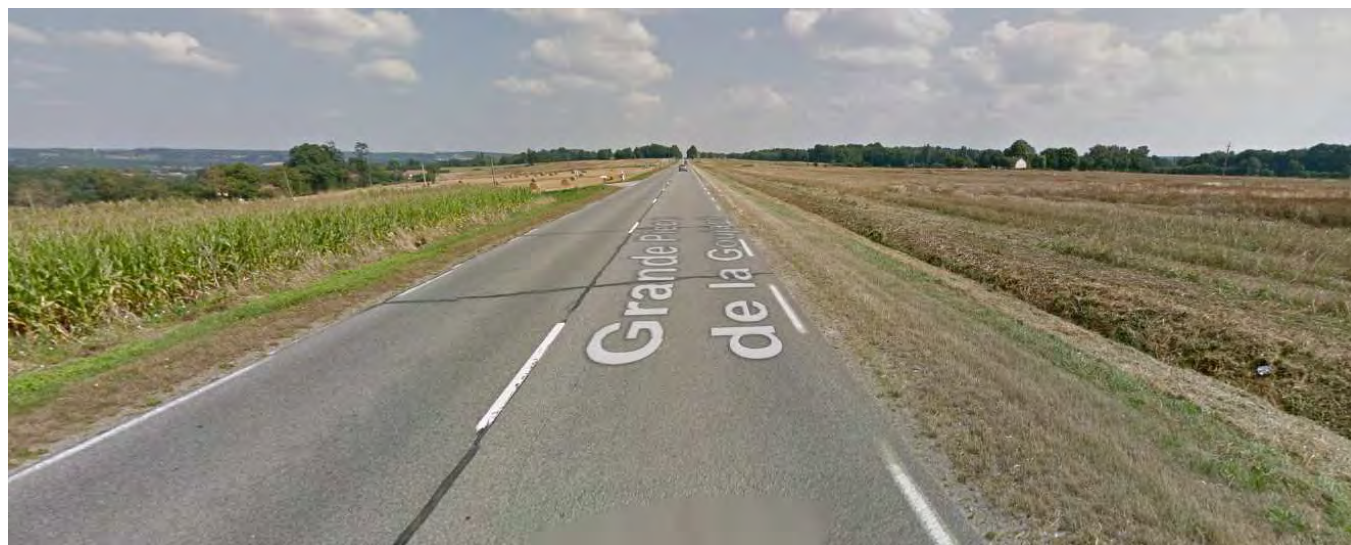
Illustration 103 : Photo de l'alignement droit entre le PR 23 et le PR 19+200 (source: Google Streetview)
