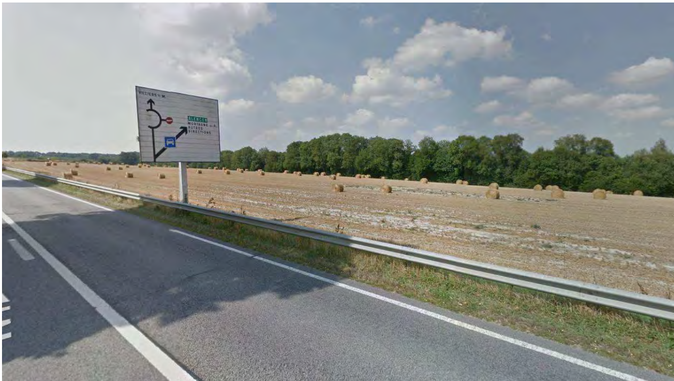
Illustration 113 : Glissières de sécurité mises en place au droit de la signalisation directionnelle (source: Google Streetview)
