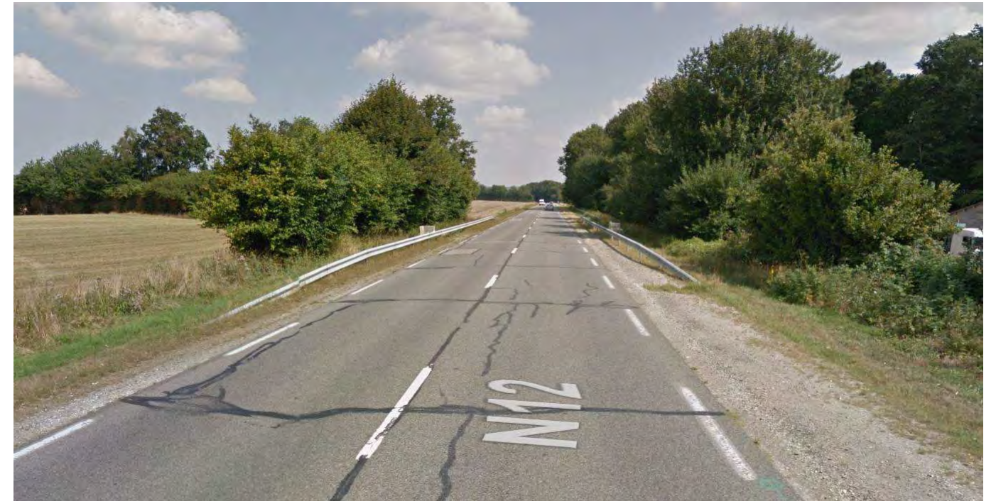
Illustration 114 : Glissières de sécurité mises en place au droit des radars (source: Google Streetview)
