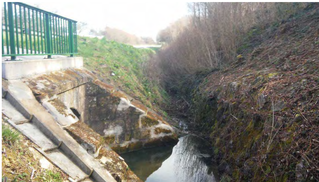
Illustration 25 : Photo du fossé au droit du ruisseau " La Vilette " (source : SEGIC)
