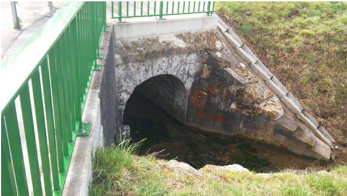
Illustration 121 : Ouvrage hydraulique de « La vilette » (source: Google earth / Google Streetview / SEGIC)
