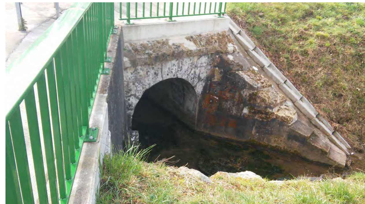
Illustration 15 : Ouvrage hydraulique de « La Vilette » (source : Google earth / Google streetview / SEGIC)
