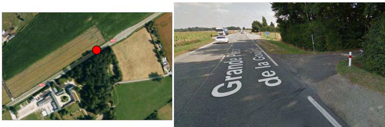
Illustration 105 : Carrefour d'accès au lieu-dit « La Goujarderie » (source: Google earth / Google Streetview)
