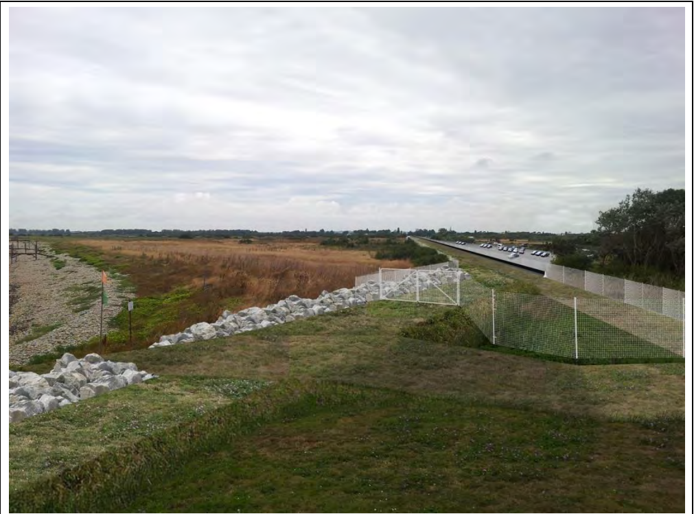
Vue après végétalisation de la digue - Vue depuis la « terrasse » de la ferme du Rocher (extrémité sud) – mois de juillet
