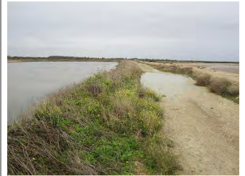
Friche sur digue SACOM, lagune à gauche
