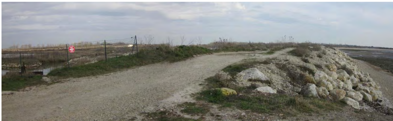
La digue existante, vue du Nord vers le Sud
