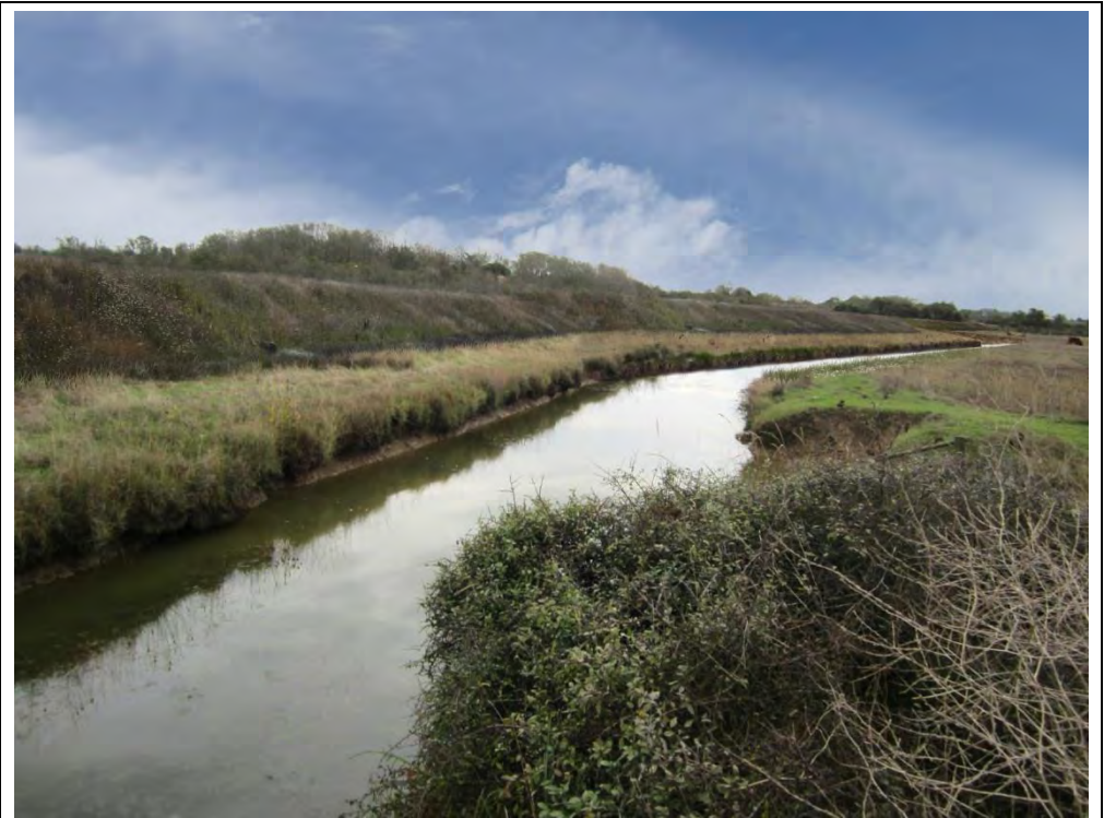
Vue après végétalisation de la digue – prairie le long du fossé syndical dans la zone de franchissement par la digue – mois d'octobre
