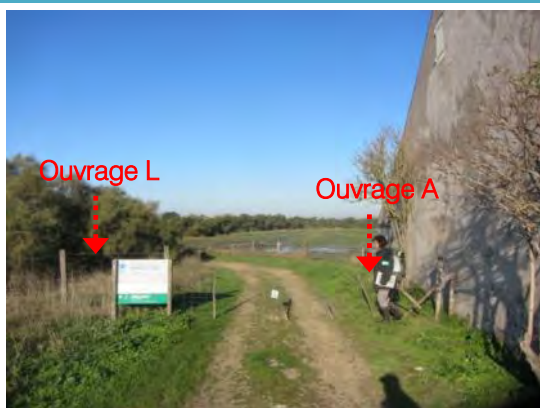
Vue sur le chemin d'accès franchissant les ouvrages L et A
