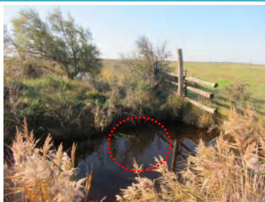
Vue sur le merlon d'implantation de l'ouvrage
