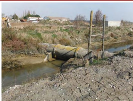
Vue sur la buse transitant par l'étier à l'amont du remblai
