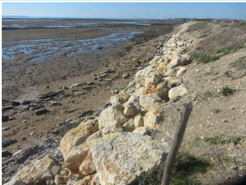
Vue sur la portion de digue reconstruite et fortement rehaussée après Xynthia côté Nord (cote 6.00 mNGF)
