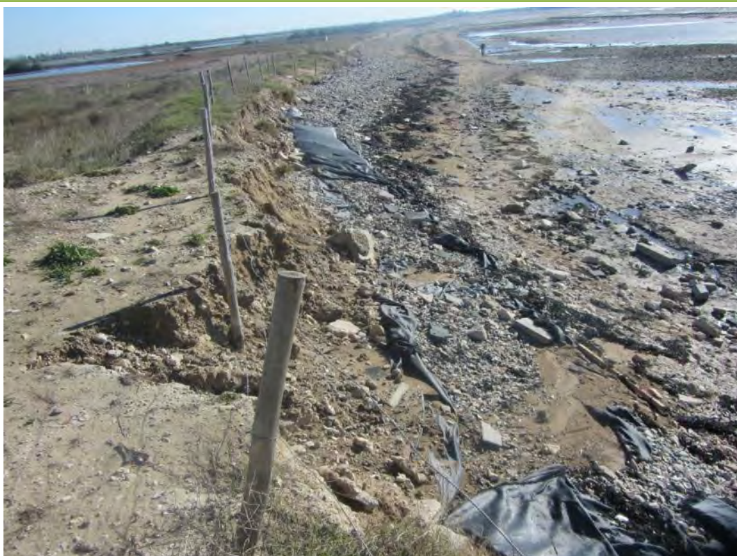
Erosion à la jonction entre le cordon dunaire et la zone SACOM (extrémité nord du cordon)
