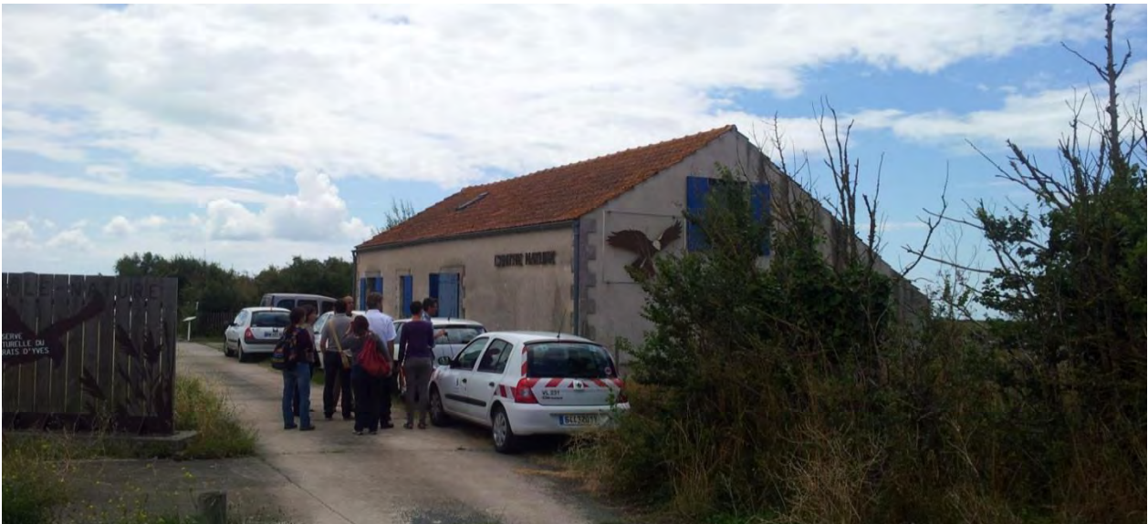
Figure 121 : Illustration photographique du Centre Nature sous emprises, le long de la RD137
