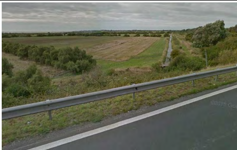
Vue avant travaux – depuis la RD 137
