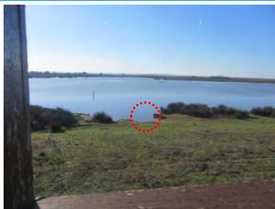
Localisation de la conduite d'alimentation de la lagune depuis l'observatoire
