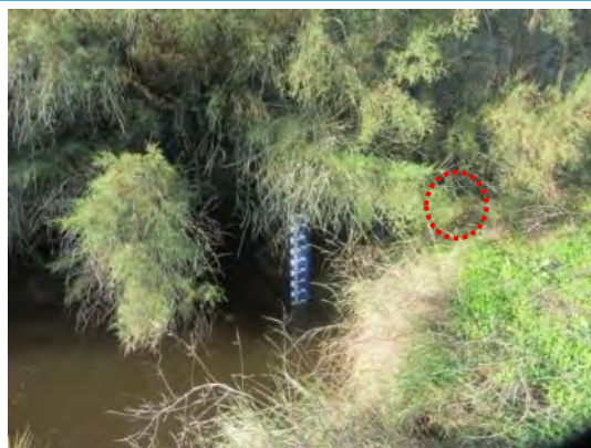
Vue échelle limnimétrique juste en amont de la buse L (cachée par la végétation)
