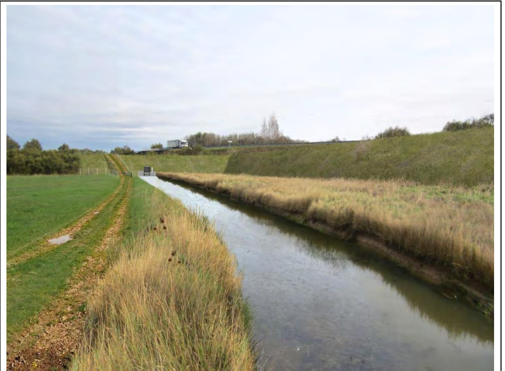
Vue après végétalisation de la digue – Angle du fossé syndical et de la RD137 (talus routier) – mois d'octobre
