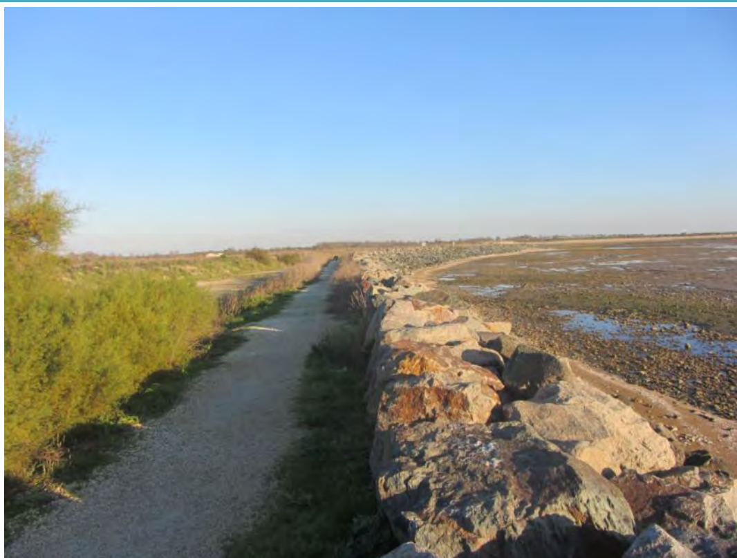
Vue sur le talus enroché (vers le sud) – cote de la crête des blocs à 4.50 mNGF
