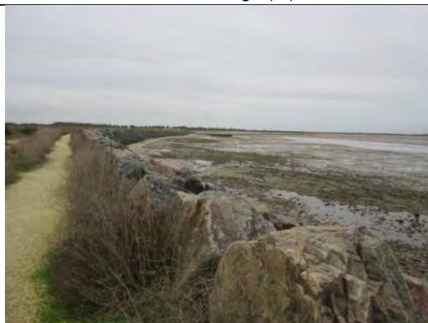
Photographie 18 : enrochements en bordure sud de la zone ostréicole
