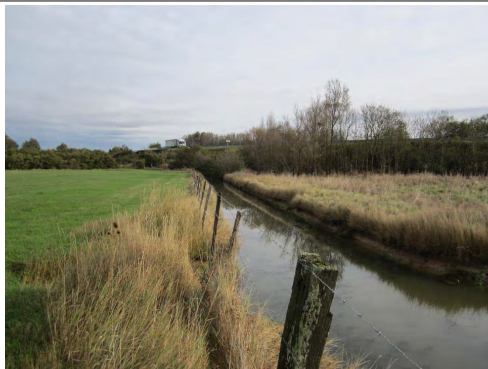
Vue avant travaux – Angle du fossé syndical et de la RD137 (talus routier) – mois d'octobre
