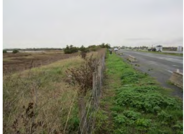
Photographie 22 : bordure de stationnement
