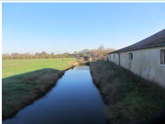
Vue sur le fossé syndical côté nord, depuis l'ouvrage A
