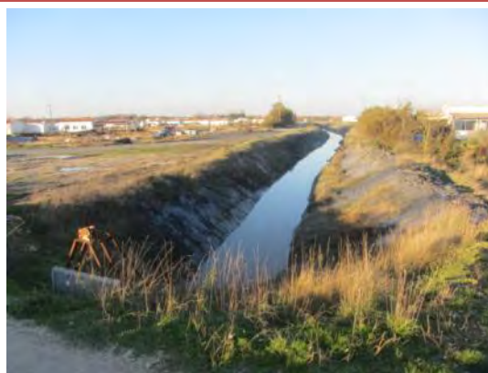
Vue sur le fossé et la tête d'ouvrage côté terre
