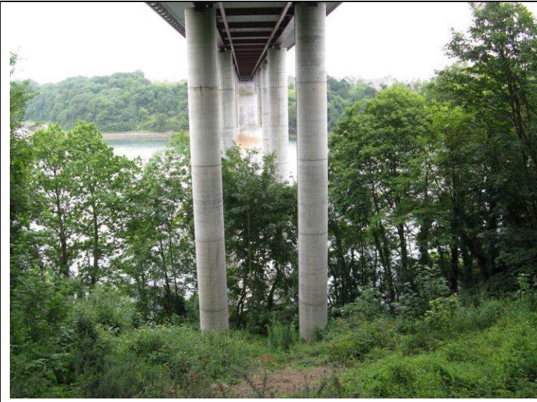
Photographie 4 (n°4 sur Figure 99: Localisation des prises de vue) La végétation sous le pont Châteaubriand, habitat qui n'est pas d'intérêt communautaire jusqu'à la pile P2, et peut être déterminée en 9180.1* de la pile P2 jusqu'à la rive
