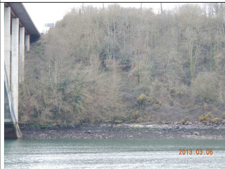
Photographie 6 (n°6 sur Figure 99: Localisation des prises de vue) Le boisement côté ouest de la Rance
