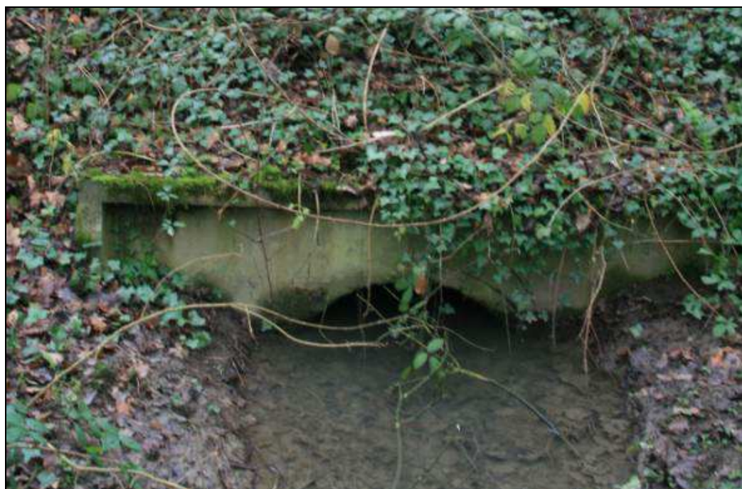
Figure 9 : Vue de la buse existante (source ARCADIS)
