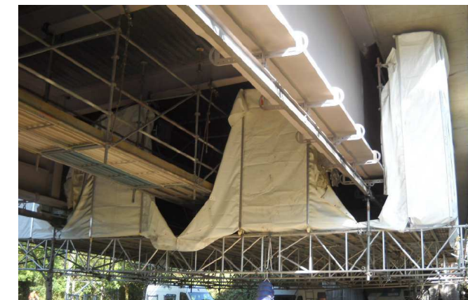
Figure 111 : Exemple de zone confinée pour le renouvellement de la protection anti-corrosion du viaduc de la Sèvre à Nantes (source CEREMA)
