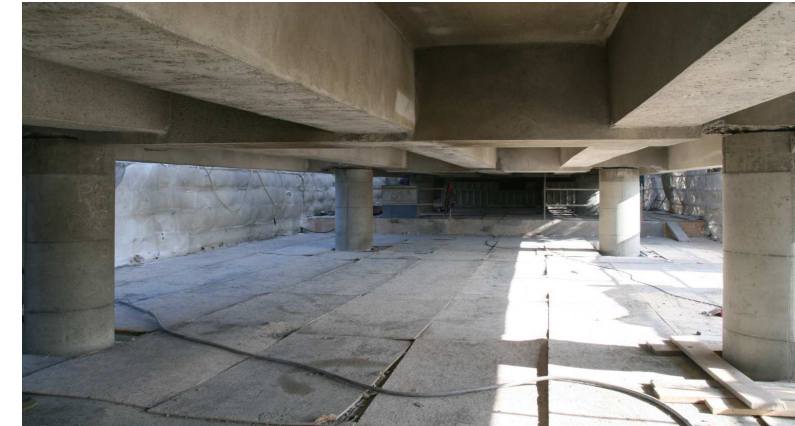
Figure 110 : Exemple de chantier d'hydrodémolition et reconstitution du béton d'enrobage - Pont de Kérisper (source CEREMA)
