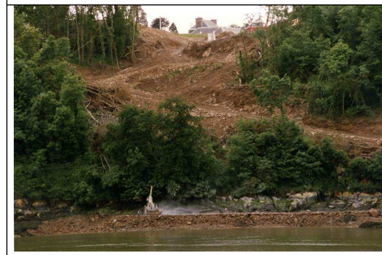
Photographie 8 de 1989 lors de la réalisation du pont La piste créée dans le boisement : le terrain a été complètement remanié.
