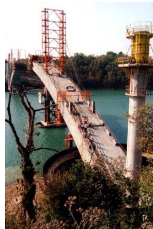
Photographie 44 : Construction du fléau rive droite
