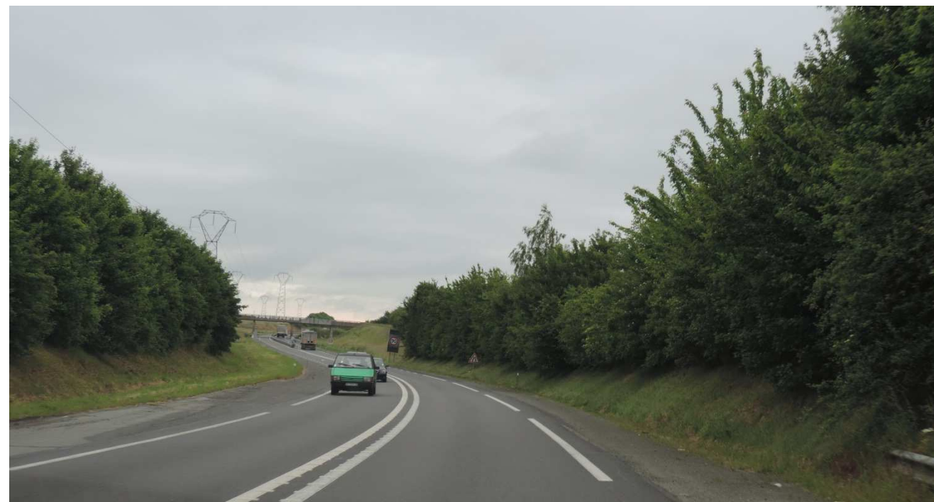
Photo 23 : L'effet de tunnel créé par la forte présence de la végétation (Source : Gingko)
