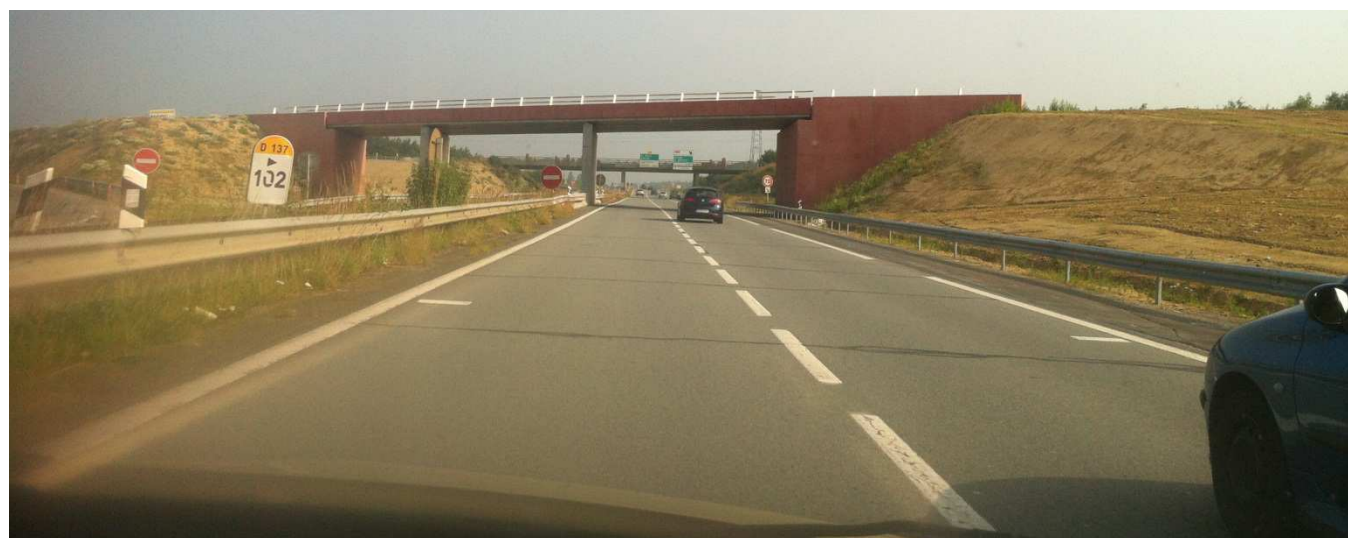
Photographie 50 : La RD137, vers Saint-Malo, au droit de l'échangeur de la Chênaie en cours de restructuration
