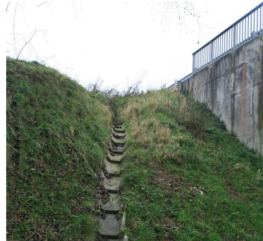
Photographie 48 : Descente d'eau en provenance de la RN176
