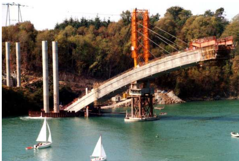
Photographie 43 : Construction du fléau rive gauche
