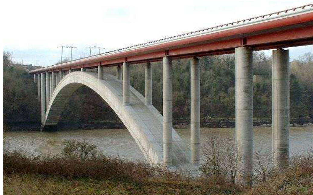
Photographie 42 : Le pont Châteaubriand franchissant l'estuaire de la Rance
