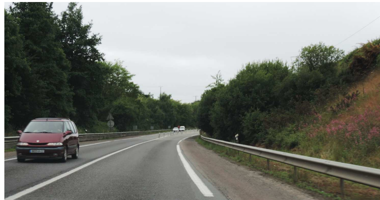
Photo 26 : L'effet tunnel revient sitôt sorti du pont Chateaubriand (source AEPE)
