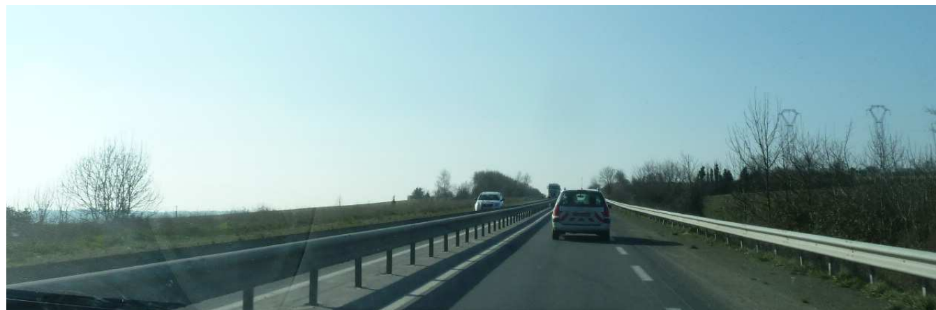
Photographie 40 : La RN176 actuelle entre l'échangeur de la Chênaie et le pont Châteaubriand
