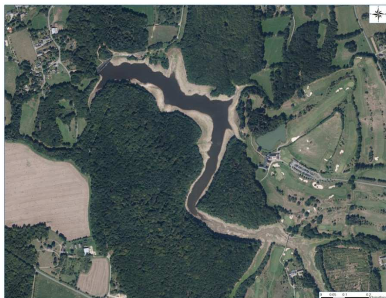
Figure 82 : Vue aérienne du barrage de Mireloup
