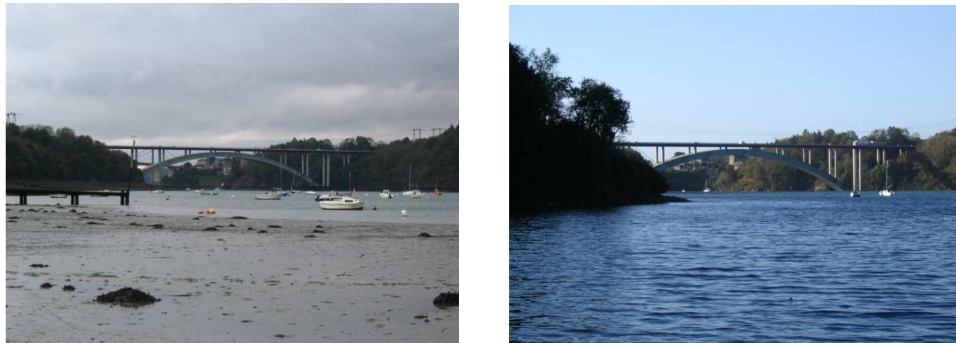
Figure 11 : La Rance franchie par le pont Chateaubriand
