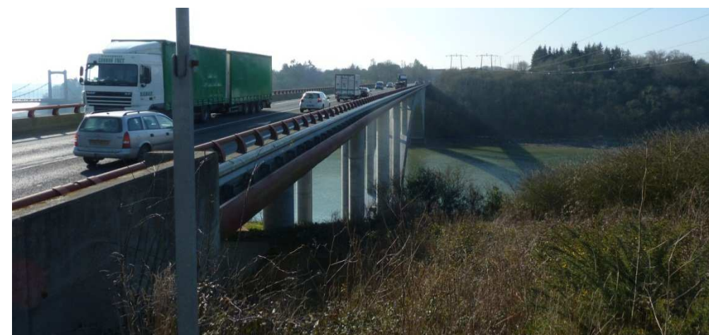
Photographie 45 : La RN176 franchissant l'estuaire de la Rance
