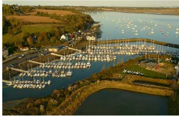
Figure 44 : Port de plaisance de Plouër-sur-Rance
