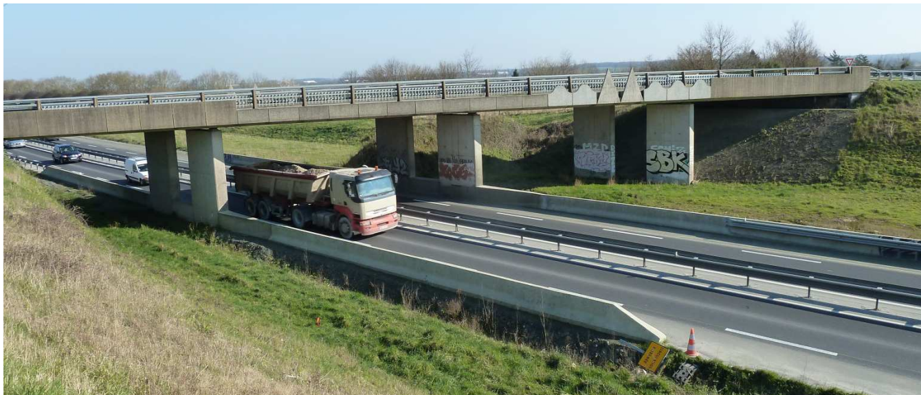
Photographie 53 : Le pont de la RD366 franchissant la RN176
