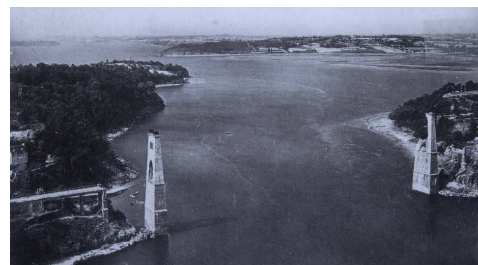
Photo 7 : Le pont Saint-Hubert en construction 1928-1929 (Source : AD Ille-et-Vilaine)
