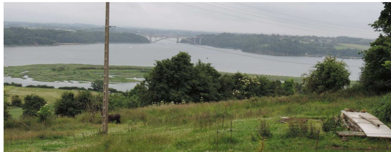
Photo 28 : POINT DE VUE 1 - Depuis le Mont Gareau, les deux ponts se confondent (Source : Gingko)
