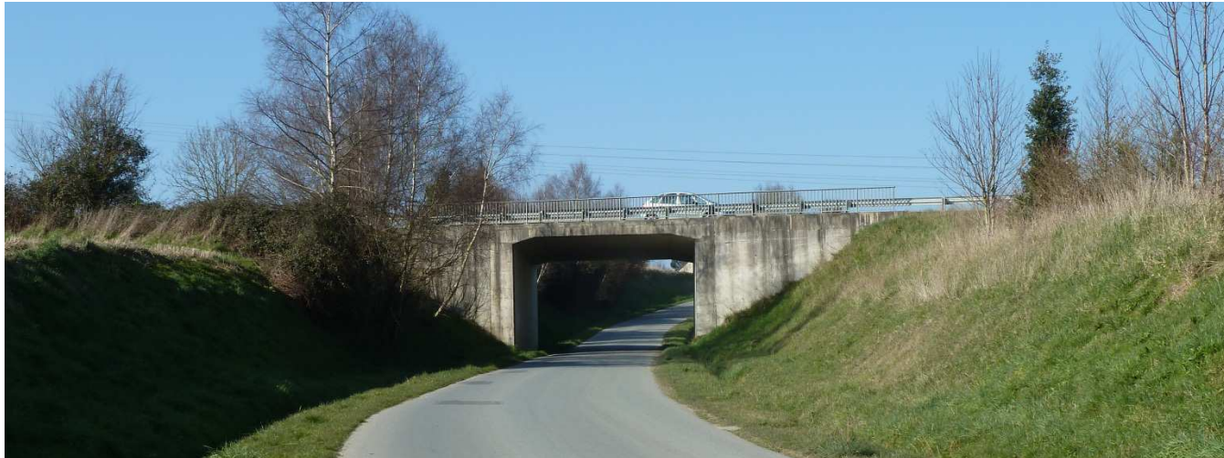
Photographie 52 : La RD407, au droit de son franchissement par la RN176
