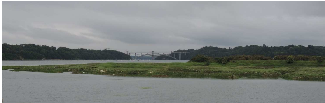
Photo 2 : La vue depuis le chemin longeant l'anse de Vigneux. Co-visibilité entre les ponts et l'enceinte médiévale (source AEPE GINGKO)
