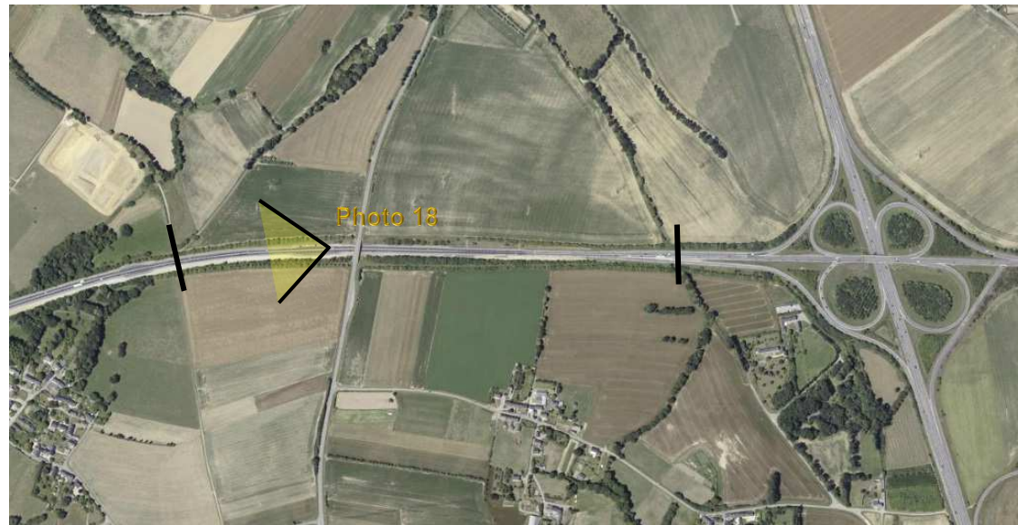
Photo aérienne 4 : Le tronçon 1 (Source Géoportail)
