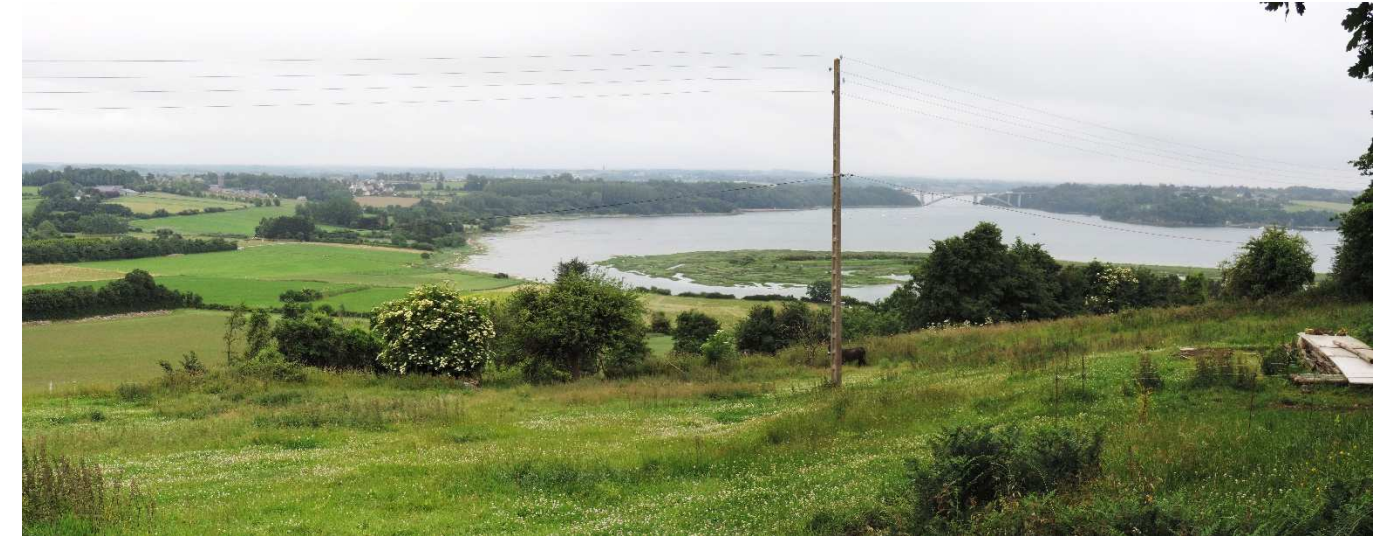
Photo 29 : Depuis le Mont Gareau, les deux ponts se confondent (Source AEPE GINGKO)
