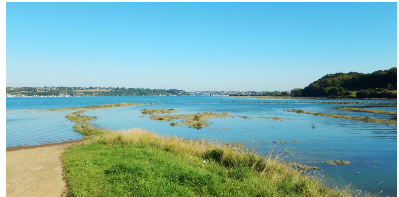
Photo 34 : Les deux ouvrages du pont se mêlent depuis la cale de Mordreuc (Source AEPE GINGKO)
