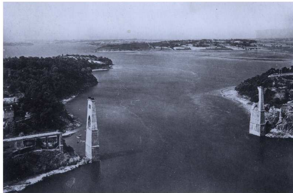
Photo 5 : Le pont Saint-Hubert en construction 1928-1929 (Source : AD Ille-et-Vilaine)
