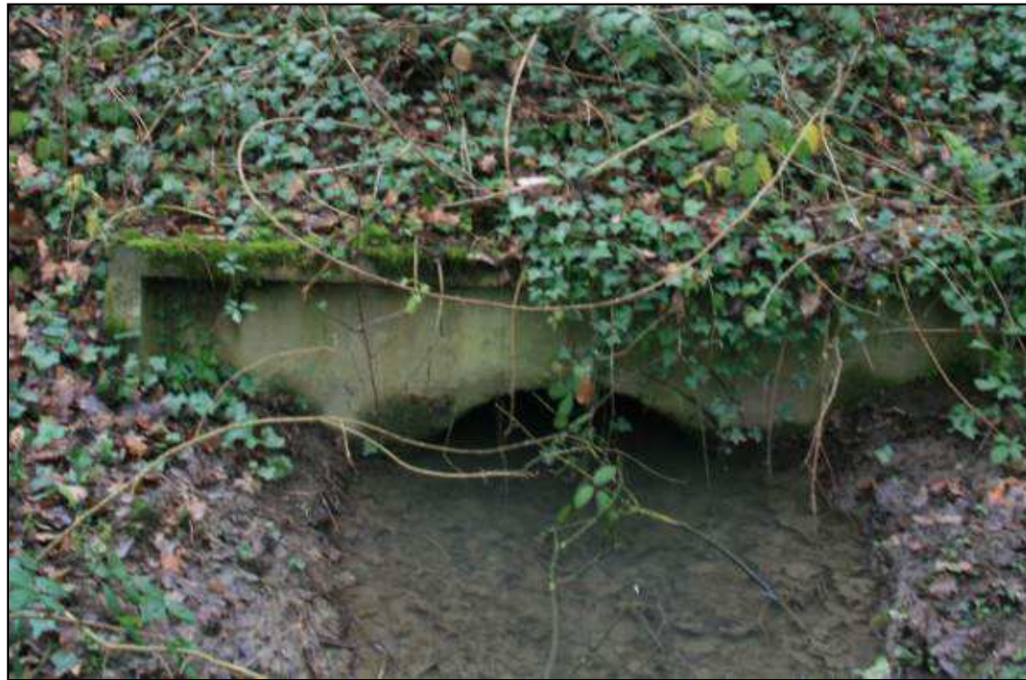
Figure 31 : Vue de la buse existante (source ARCADIS)
