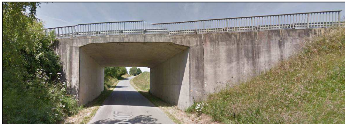
Figure 22 : Vue du PI de la RD407 côté élargissement au Sud (source Google Street View)
