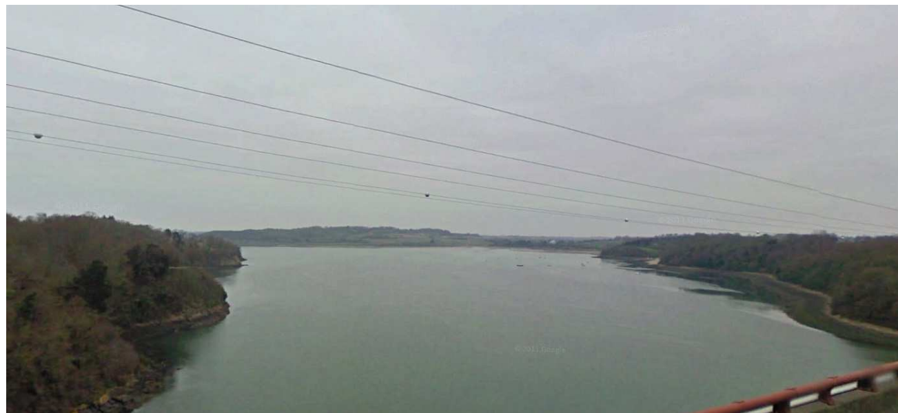
Photo 27 : Vision panoramique vers le nord (Source StreetView 2009)
