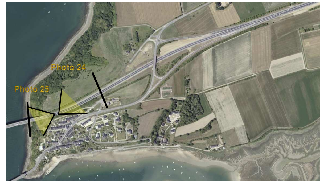
Photo aérienne 8 : Le tronçon 5 (Source Géoportail)
