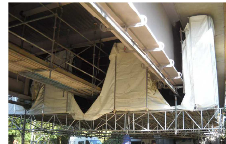
Figure 107 : Exemple de zone confinée pour le renouvellement de la protection anti-corrosion du viaduc de la Sèvre à Nantes (source CEREMA)
