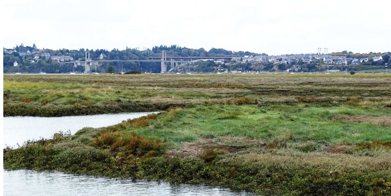
Photo 36 : La vue sur les deux ponts depuis La Coquenais. Se distinguent les deux ouvrages séparément, ainsi que la ligne électrique. Le tablier de couleur rouge du pont Chateaubriand tranche avec le bleu ardoise des toitures. La présence de Port Saint-Jean rend le point de vue sensible (Source AEPE GINGKO)
