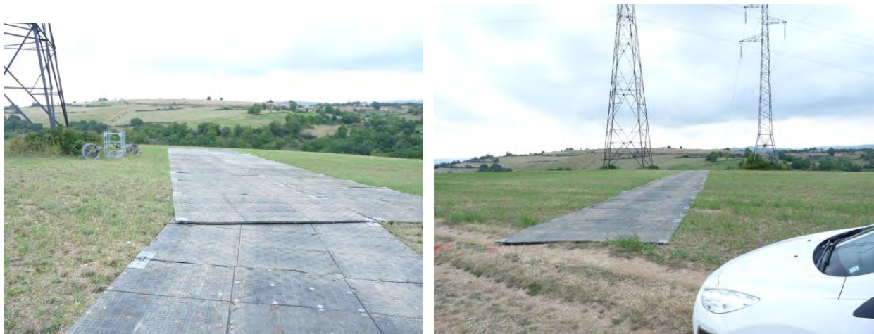
Figure 5 : Illustration de la pose de plaques temporaires (Source : RTE)
