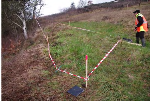
Exemple d'un balisage (piquets + rubalise) préalable aux travaux.
