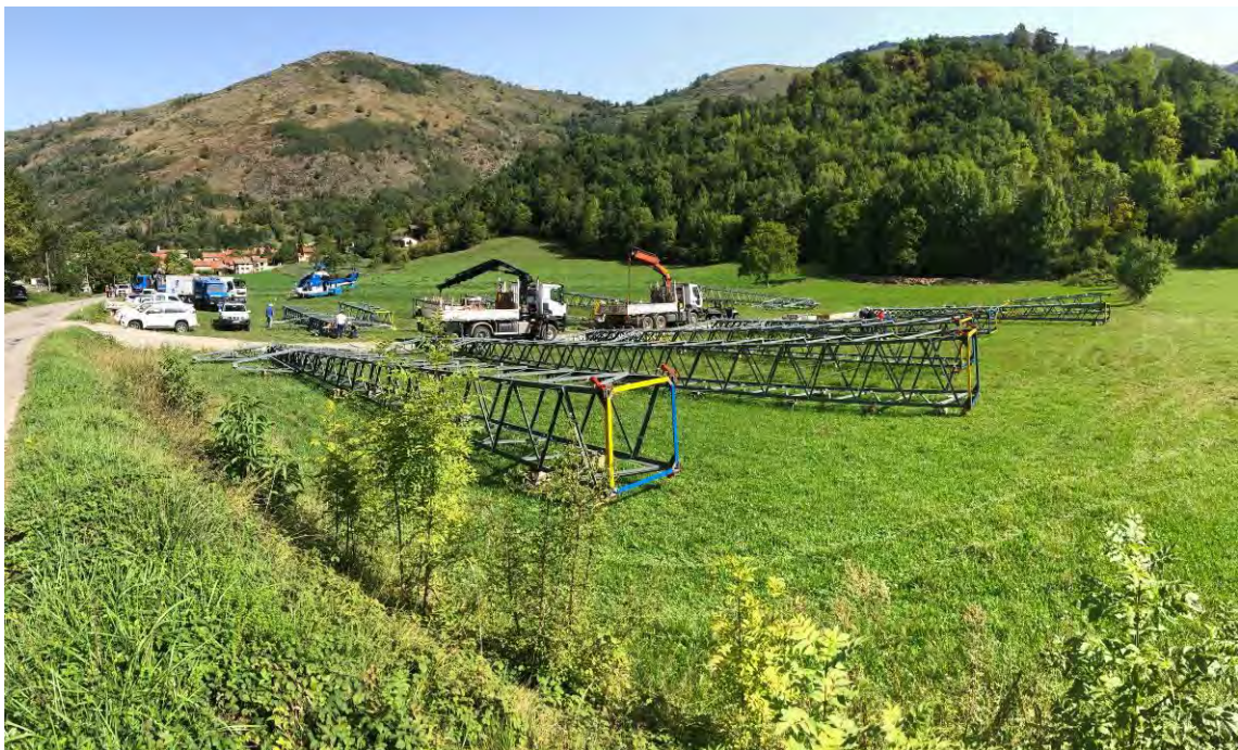
Figure 8 : Zone de montage et stockage des pylônes et zone de pose de l'hélicoptère
