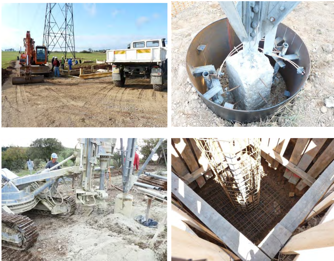
Figure 6 : Illustration de opérations de création des nouvelles fondations
