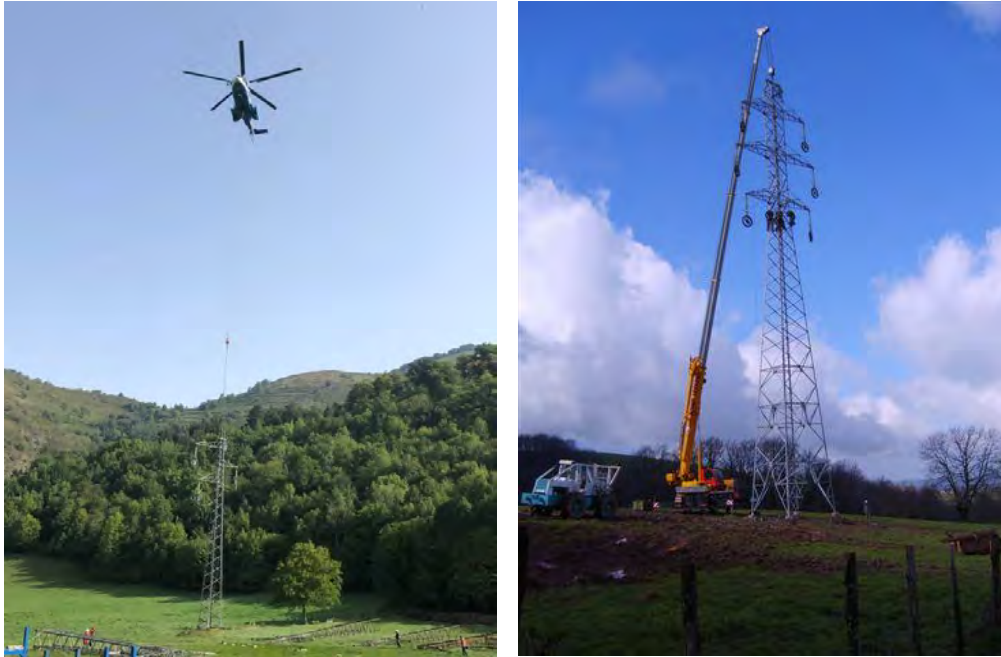
Figure 7 : Remplacement et dépose de support à l'aide de moyens hélicoptés (à gauche) ou d'une grue (à droite)
