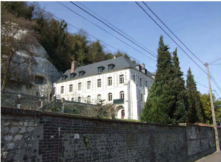
L'ancien couvent Sainte-Barbe est un bâtiment remarquable situé à Canteleu et en partie troglodytique.
