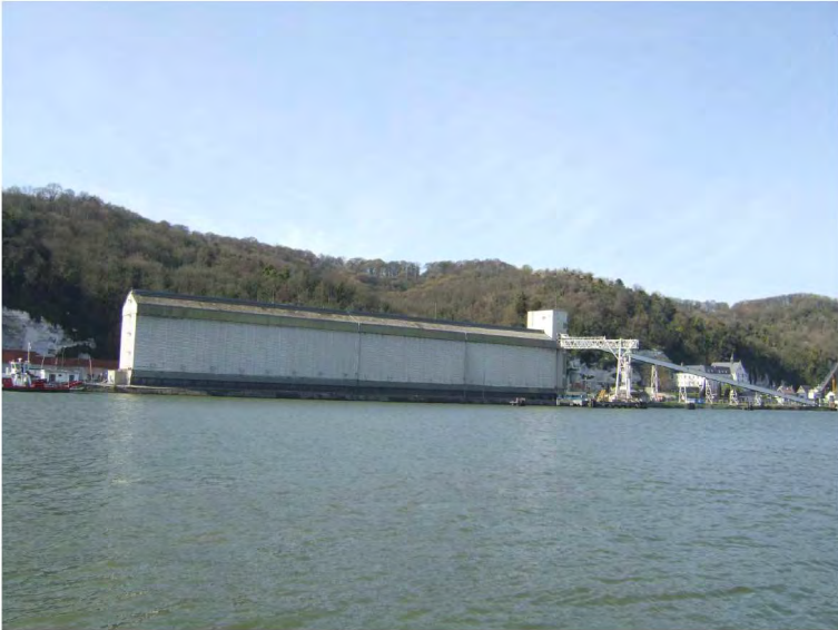
Certains bâtiments industriels ont des volumes imposants, à l'échelle des falaises et anciens fronts de taille des carrières.
