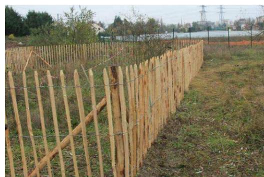
**Photo 18 : Clôtures en ganivelles autour des secteurs d'Orobanches pourprés isolés (Source : SYSTRA, 2013)**
