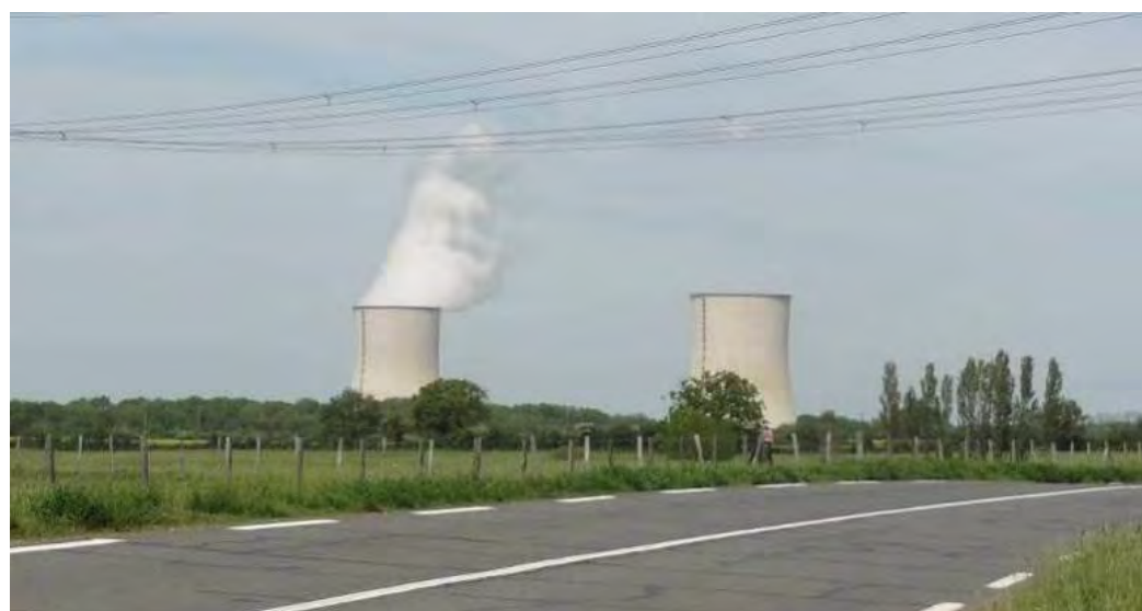
Centrale nucléaire de Civaux (Source : INGEROP)
