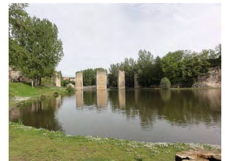
Ruines du pont levis de l'ancien château de Lussac-les-Châteaux (Source : INGEROP)
