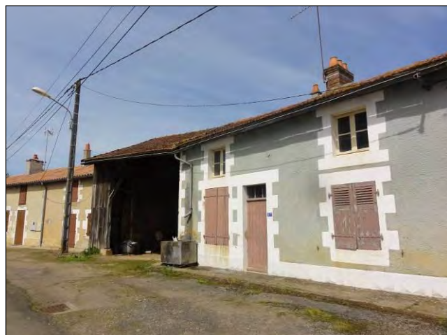
Habitat traditionnel – Persac (Source : INGEROP)
