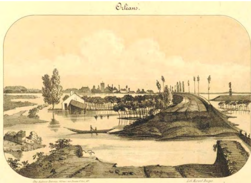
Brèche de la levée de S.Pryvé après l'inondation.
