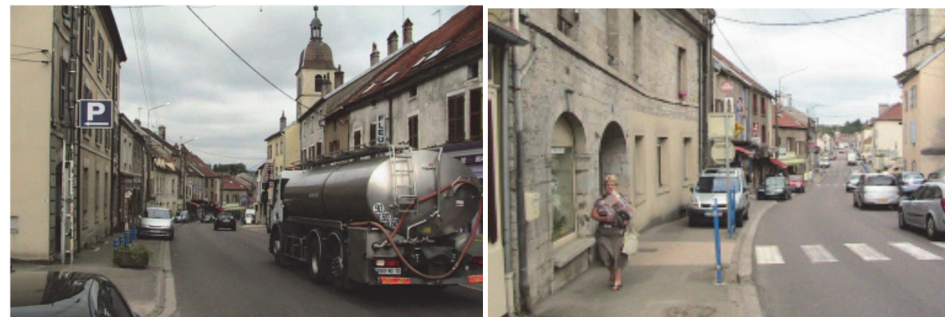
RN 19 actuelle en traversée de Port-sur-Saône
