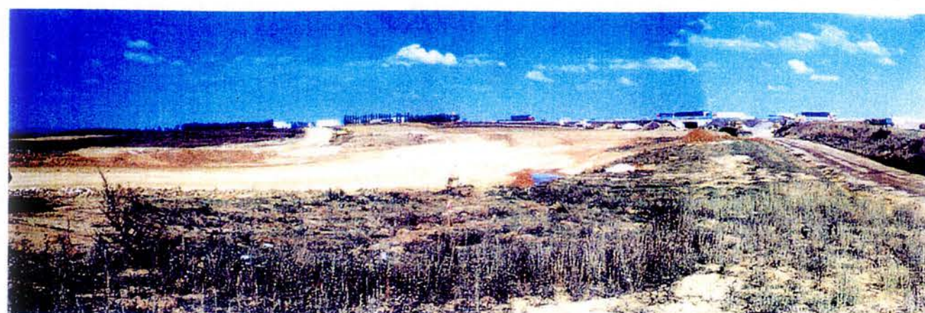
Zone d'implantation de l'échangeur avec l'A1, à l'ouest
