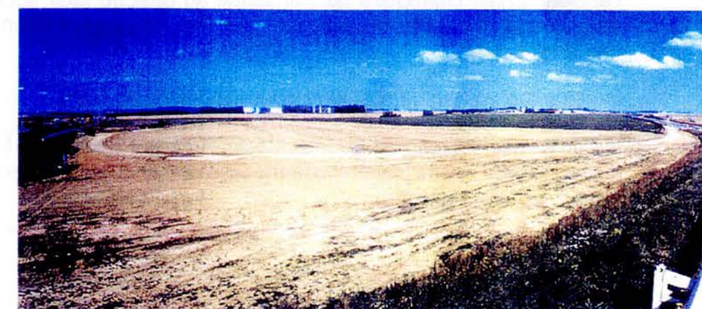
Zone d'implantation de l'échangeur avec l'A1, à l'est
