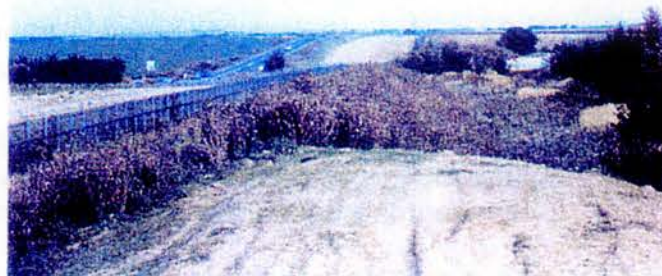
Bordure de la RD212 en direction du sud-est
