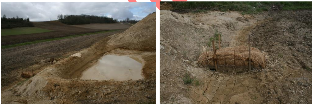
Figure 5 : Bassin de décantation étanche temporaire des eaux de ruissellement en phase de chantier avec filtre à paille en sortie
