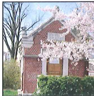
Figure 3 : Station de mesure de Belfort Octroi
