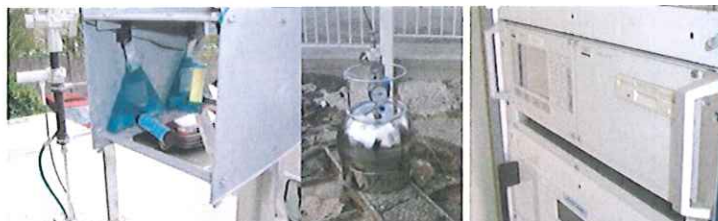
Figure 5: Capteur passif, capteur actif, et analyseur automatisé permettant d'assurer la surveillance de la qualité de l'air
